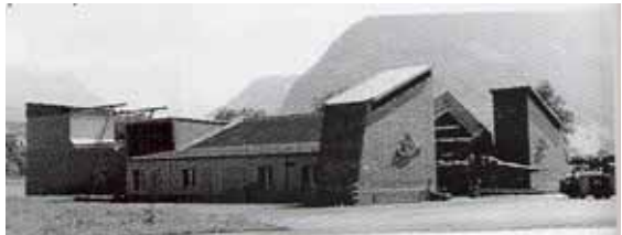
Bremszelle: Solche Zellen wurden in Dübendorf, Buochs, Emmen, Meiringen, Interlaken, Payerne und Sion gebaut. Sie erlauben, ganze Flugzeuge darin mit voller Leistung „abzubremsen“, ohne dass Lärm nach aussen dringt
