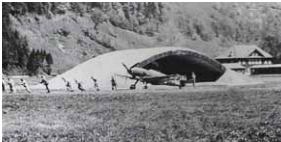
U43: Diese Unterstände waren ursprünglich vorne offen
