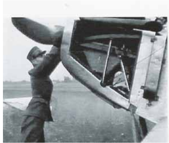
Handanwurf der Motoren.(Hier ein Leutnant in der Pilotenschule)
