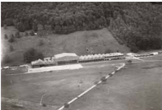
1940: Werkstattanlage in Buochs nach der Fertigstellung
