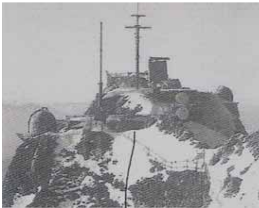
Ein „Floridaberg“: Die runden Flächen unter der Radarantenne verdecken die Antennen der Richtstrahlanlagen. Die runden Hauben links und rechts enthalten 20mm-Zwillingsflabgeschütze
