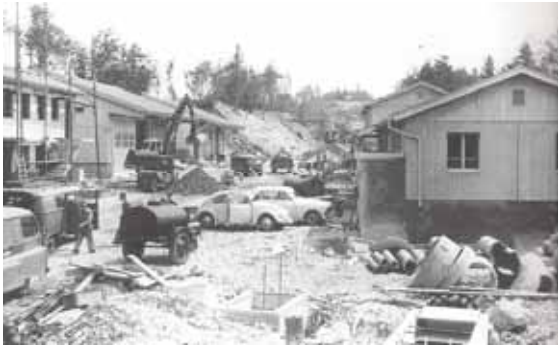
BL-64-Nebenanlagen: Unterkunft, Kommando- und Ausbildungsräume
