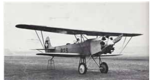
1927: Fokker CV-D mit Jupiter-Sternmotor (420 PS) Das Flugzeug hatte kleinere Tragflächen als der Typ CV-E (nachfolgend).
