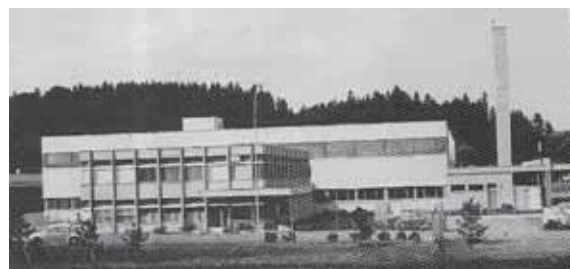
Emmen: Mit der Beschaffung der Lenkwaffe „Bloodhound“ genügte die Werkstätten in der Halle I nicht mehr. So kam Emmen zu einem neuen Werkstattgebäude.
