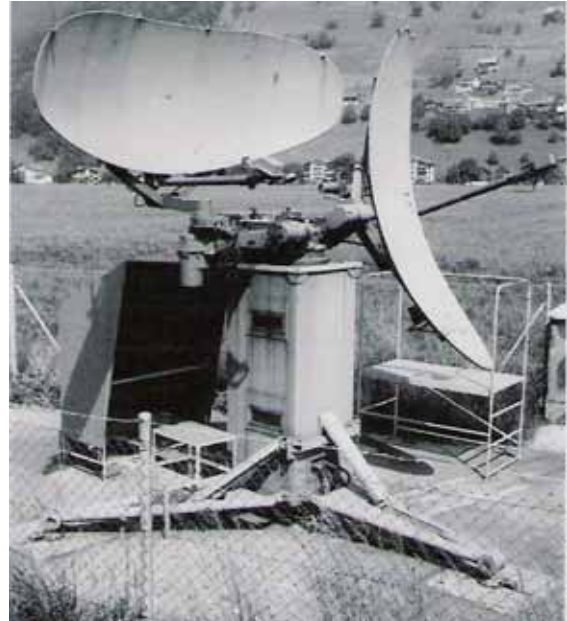
Quadradar-Antennen auf einem Kriegsflugplatz
