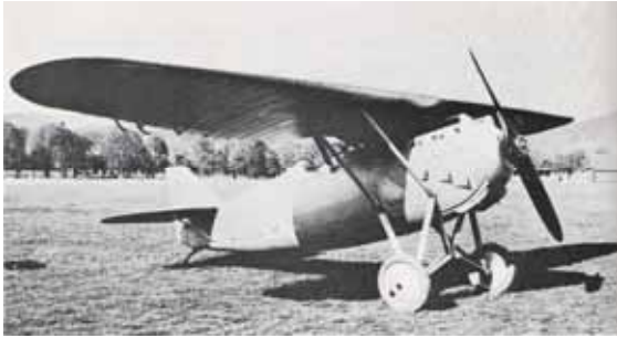
1928: Devoitine D-27 HS-57 (500PS). 65 Flz. Das Flugzeug wurde von dem nach Thun verpflichteten, französischen Konstrukteur Devoitine konstruiert und von der K+W gebaut. Die Flugleistungen waren zufrieden stellend.
