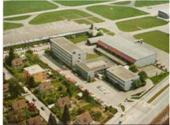
Dübendorf: Gebäudekomplex der Zentralverwaltung
