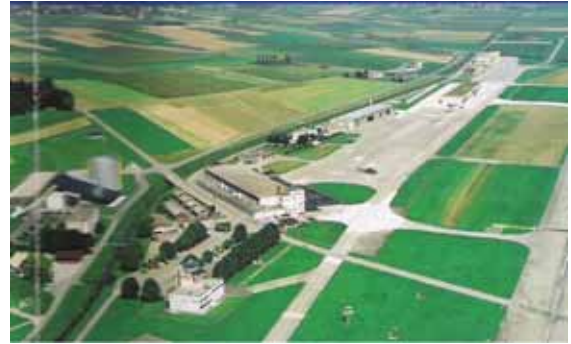
Nochmals Payerne: Blick von Westen. Vorne der Flugsicherungsturm, links vom Bach das UeG-Gebäude und dahinter der F/A-18- Simulatorekomplex
