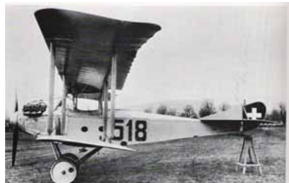
1918: DH-3 (Häfeli) mit etwas stärkeren LFW-Motor von 180 PS statt nur 150 PS beim HS-41
