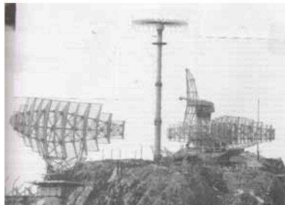
Die Antennen des ersten leistungsfähigen Luftraum-Überwachungssystems SFR und eine Peilantenne auf einer Höhenanlage
