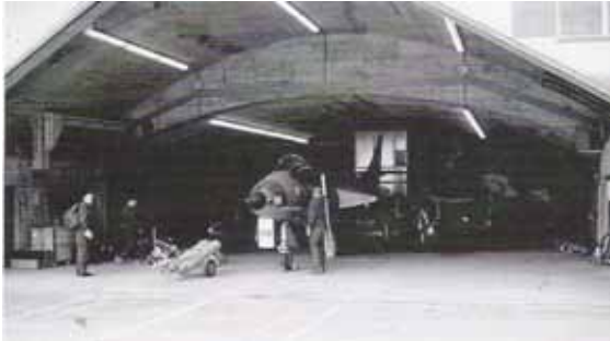
U43/68: Parallel zum Bau der U72 erhielten 26 der total 192 U43 einen ebenbürtigen Schutz wie die U72, also gegen 3 Bar Überdruck
