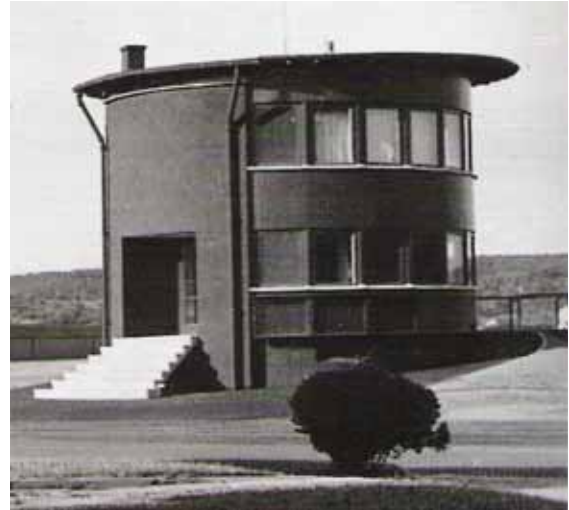
Dübendorf: Der neuere Turm um 1960 mit vollständiger Funkausrüstung, aber noch ohne Radarüberwachung
