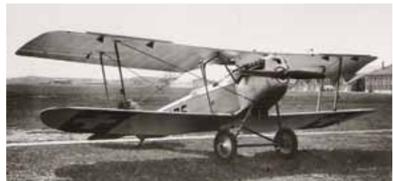
1929: DH-5A. (MVa) K+W, Thun. Stahlrohrumpf. Es wurden 20 Flz mit dem etwas stärkeren Motor LFW III beschafft. Auch wurde dieses Modell von Anfang an mit dem Spaltflügel von Handley Page ausgerüstet.
