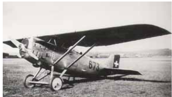
1926: Devoitine . D-19 C-1. HS-52 (400PS). 3 Flugzeuge wurden in Einzelteilen in Frankreich beschafft und in der K+W zusammengebaut. Das Flugzeug wurde eingesetzt, befriedigte aber nicht. Der Motor war auch in diesem Fall zu schwach.
