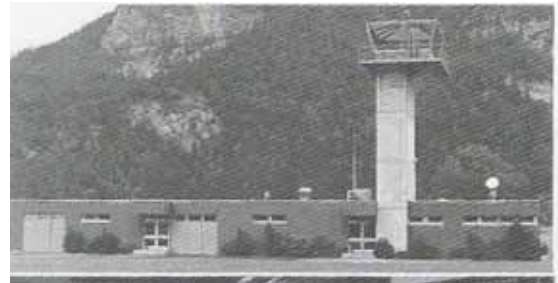
Meiringen heute: Im Turm ist die modernste Elektronik installiert
