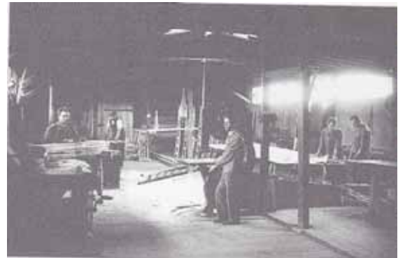
Hier wird an einem Flz DH-3 „geschreinert“
