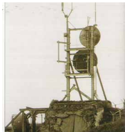
Offene Richtstrahlantennen (Parabolspiegel) mit Funkantennen auf einer Bergfunkstation
