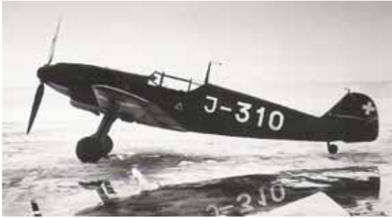
1938: Messerschmitt Me-109D „David“ 10 Flugzeuge wurden von Messerschmitt geliefert. Das Flz Me 109D hatte einen Motor Jumo 210D von 680 PS und diente als Vorstufe zum stärkeren Flz Me- 109E.
