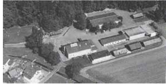
Stans „Risismühle“: „Nach- und Rückschubzentrale. Hinter der Halle (oben im Bild) sind die Zugänge in die unterirdischen Lagerkavernen erkennbar
