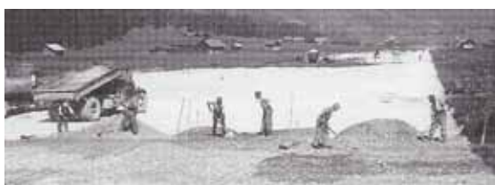
Bau von Hartbelagspisten
