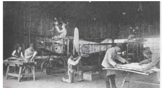
Reparatur an einem Flz DH-3
