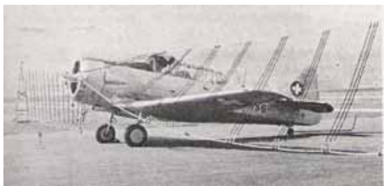
Das Notlandenetz „BEBAB“: Die Fangstrippen haben seitlich grosse Abstände
