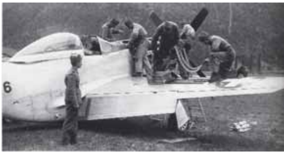
Munitionieren des Flz P-51 „Mustang“
