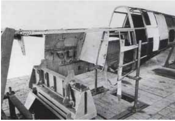
Ein Me-109E Rumpf nach Bruchlandung auf einer Rumpflehre zum Neuaufbau bereit
