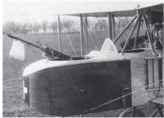
DH-1: Der Beobachter hatte vorne im Bug ein Maschinengewehr auf einer Drehlafette montiert. Der Sack vorne am MG fängt die Hülsen auf, sonst würden sie in den hinten drehenden Propeller gelangen und diesen beschädigen.
