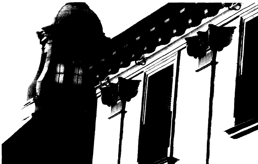
Fig. 11. Detalle de la cornisa y capiteles de la fachada que da a la calle de Santa Isabel. Las volutas que coronan las pilastras adoptan la forma de hoja de cardina. Las ménsulas, hoy de piedra, de Valentin Roca y Carbonell, fueron hasta 1905 de madera de pino (Archivo de la Villa, legajo 16-43-11).
