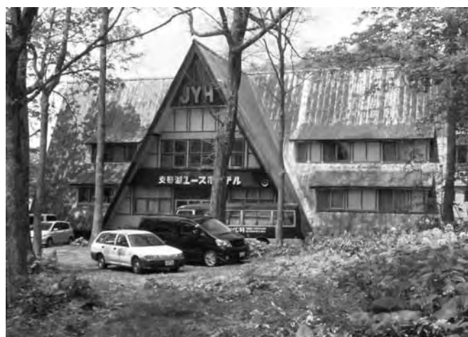
写真 - 11 改修が必要な支笏湖ユースホステル旧館
