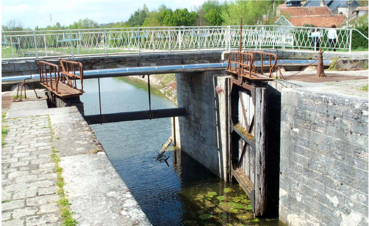
Photo II-1 : Conduite en aval immédiat du pont de l'écluse de Combleux
