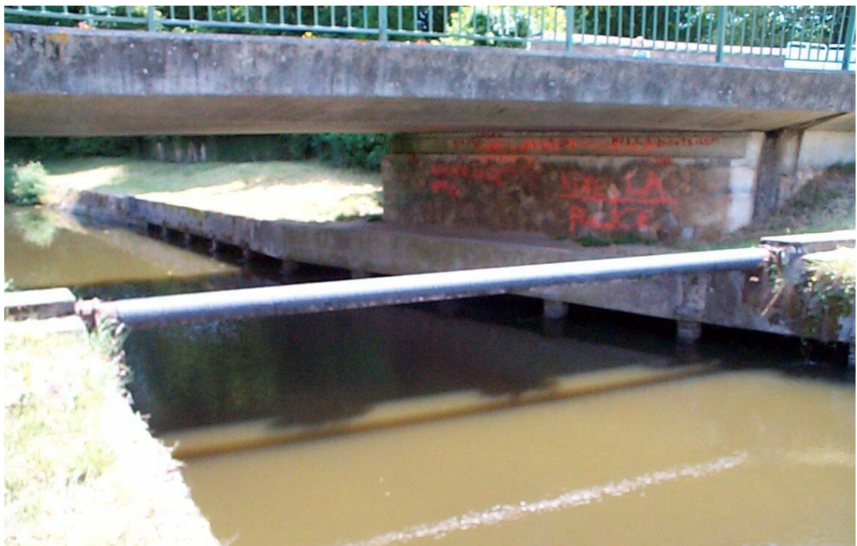
Photo II-2 : Conduite sous le pont de Vitry aux Loges en aval de l'écluse de Vitry
