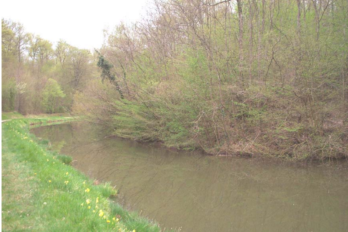
Photo II-3 : Glissement de berges entre Vitry et Combreux au lieu dit « la Montagne »
