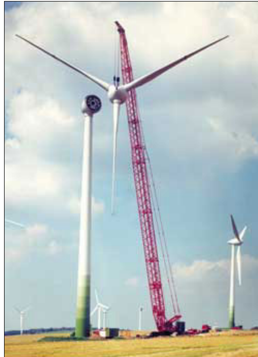
Montage einer E-66
