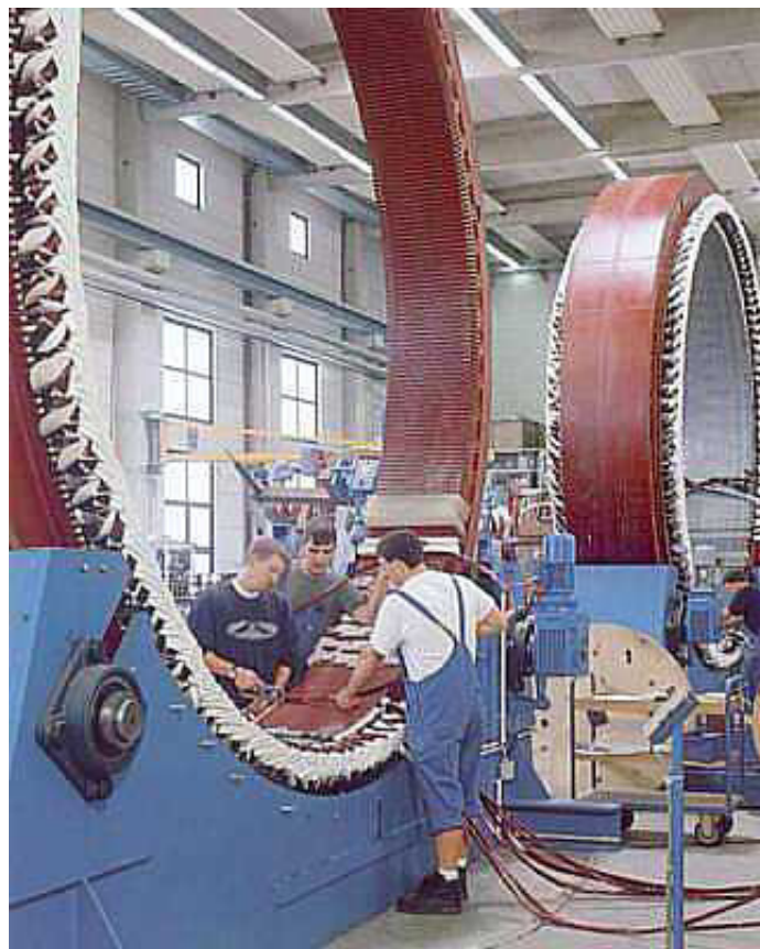
Wickeln des Stators
