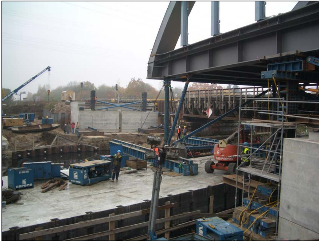
Vorbereitung des Verschubes
