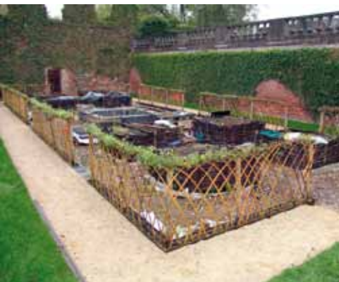
Le jardin des carrés en cours de réalisation © Abbaye de Villers-la-Ville asbl
