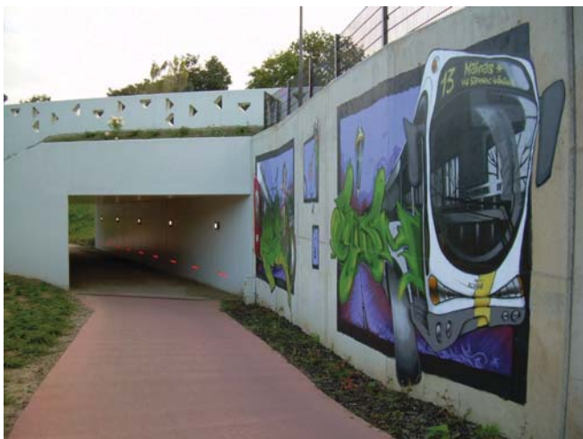
Unterführung eines Radschnellweges in der Region Antwerpen. © Provincie Antwerpen www.provant.be
