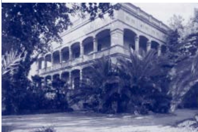
Edifici i jardí de la Colònia Gasol, de Bítém (Tortosa). Fotografia: autor desconegut. [1934]. ANC. Fons Generalitat de Catalunya (Segona República) .
