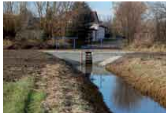
Staubauwerk Marstallwiesen (Foto: H. Rößling)
