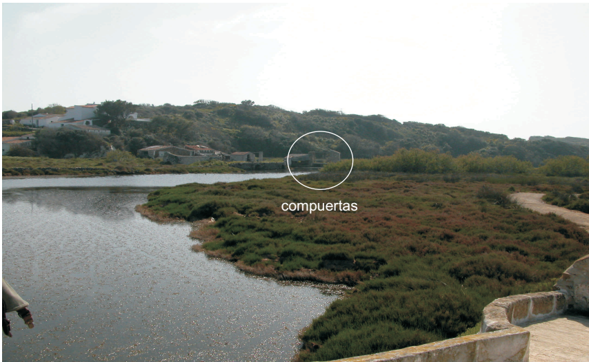
Figura 4 Sistema de compuertas para regular la comunicación entre la albufera y el mar.
