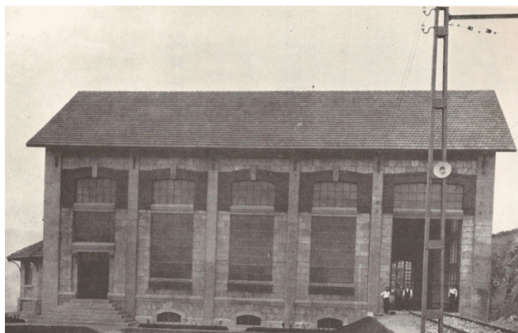
Fig. 3.- Subestación eléctrica de Pajares en 1924. En la actualidad el edificio se mantiene en estado similar al de la imagen aunque los ventanales han sido tapiados. (GE Bulletin)
