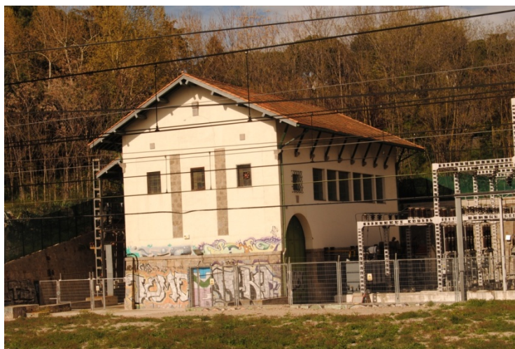
Fig. 7.- Electrificación de Madrid a Ávila y Segovia, subestación convertidora de Príncipe Pío. Proyectadas en 1933, no se concluyeron hasta después de la Guerra Civil. Los vanos originales de la fachada frontal han sido cegados y sustituidos por pequeños ventanucos. Fuente: Autor
