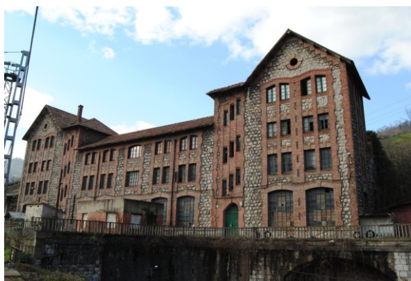
Fig. 1.- Depósito-taller de locomotoras eléctricas de Ujo. Fachada principal en la actualidad, compuesta por la zona de viviendas y despachos del edificio. Fuente: Autor.
