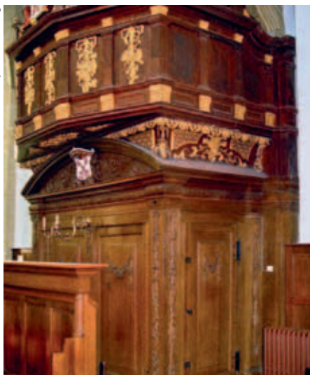
Op deze foto is goed te zien hoe de stadstimmerman, Pieter van Drongen, door het aanbrengen van lijsten en vullingen ervoor zorgde dat het orgelbalkon goed bij het houten portaal aansloot.
