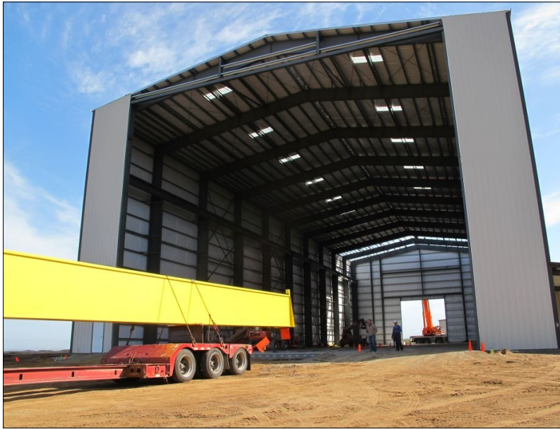
Foto - Constructie van de nieuwe faciliteiten rond de lanceerinfrastructuur zijn volop bezig. Om binnen twee jaar zo'n duizend tal mensen tewerk te kunnen stellen.
