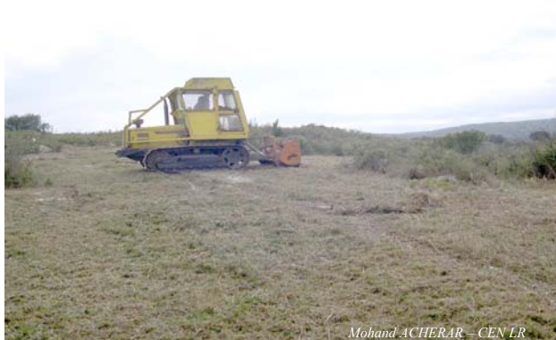
Exemple de mesure de gestion : Travaux de débroussaillage dans le massif des gorges du Gardon (Gard)
