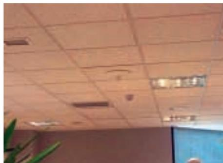
*Antena de una estación base picocelular*
