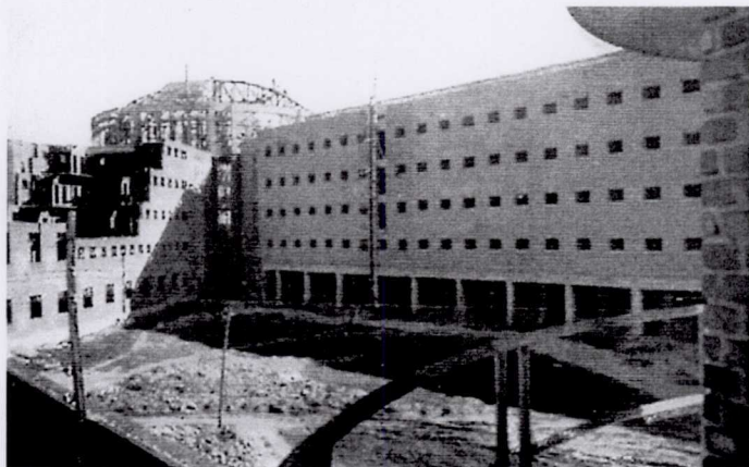
Fachada y galería con estructuras vistas de hormigón armado.
