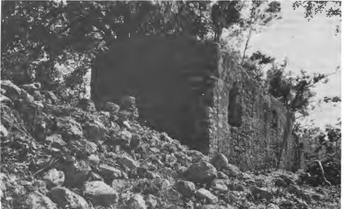
11. Fachada poniente de la casa.
