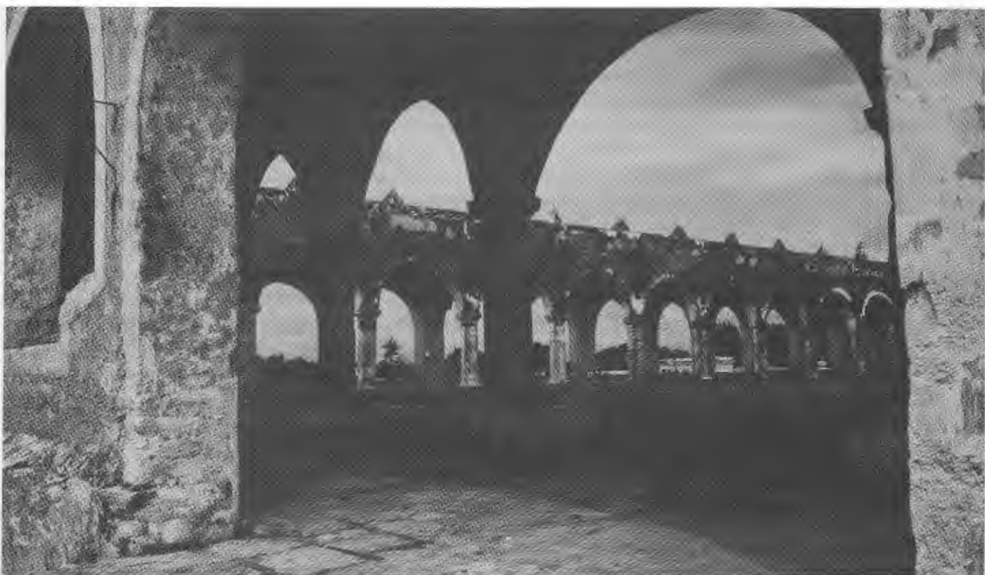
Aspecto de las arquerías desde el acceso oeste del atrio.
