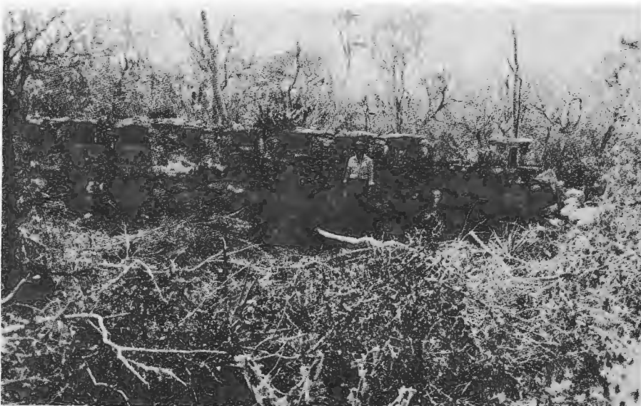
Fot. 2. Frente norte del parapeto. Conjunto A, Chuburná, Yuc. Foto Barrera Rubio.
