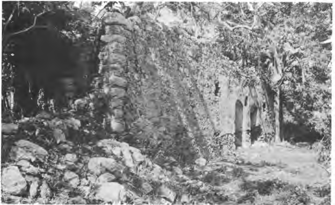
9. Fachada oriente de la casa.
