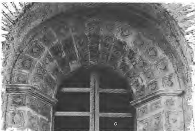
10. Detalle de la ventana en el muro sur del templo del Ex-Convento de Santa Clara en Dzidzantún. Foto P. Chico.
