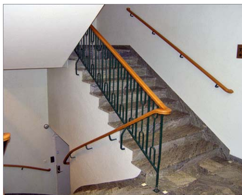
Trapphuset i byggnadens mitt. Från entrén. Nbm acc.nr 2006:159:06
