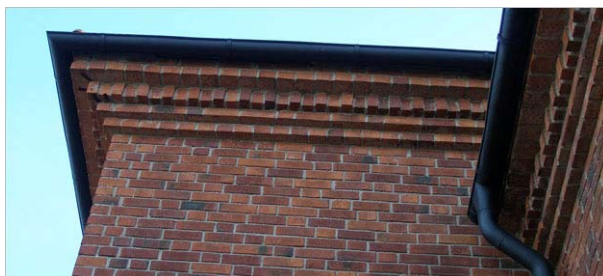
Takfot och trappstegsfris. Nbm acc.nr 2006:158:18
