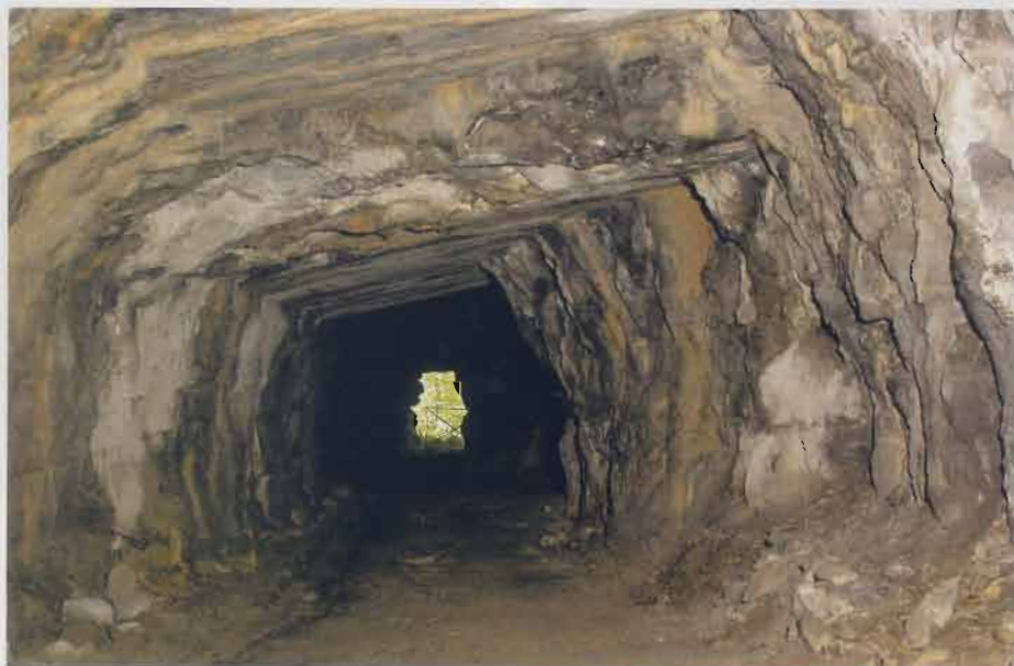
Sullo sfondo s'intravede uno degli ingressi della Miniera di Santo Spirito. Le gallerie venivano scavate perpendicolari alla parete d'ingresso e tutte parallele fra loro con molti condotti comunicanti. (Foto C. Iacovone)
