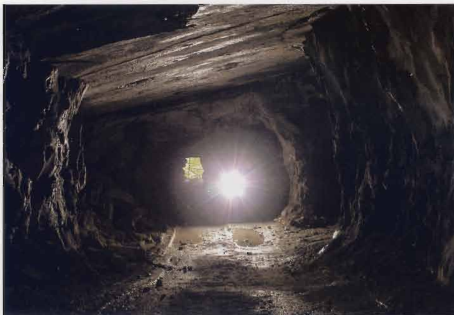
In questa suggestiva foto si può notare come l'inclinazione della volta segue l'andamento naturale dello strato contenente il bitume. (Foto C. Iacovone)
