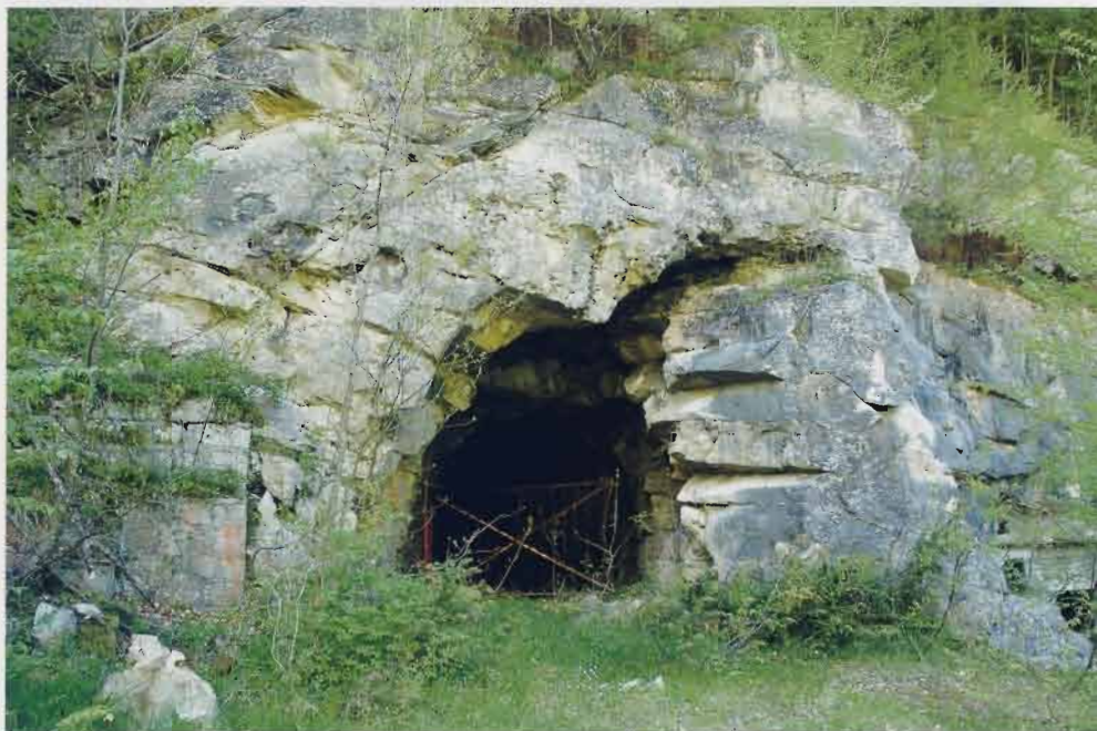
Uno dei tanti ingressi della Miniera di Santo Spirito. Gli accessi molto grandi consentivano ai camion di entrarvi per un certo tratto e caricare le rocce asphaltiche. (Foto C. Iacovone)
