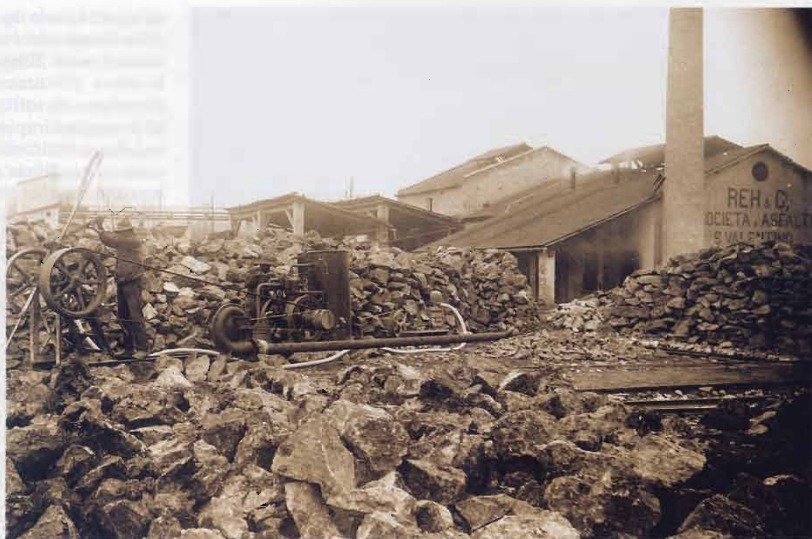
Deposito di rocce asfaltiche pronte per la lavorazione nello stabilimento della Reh & C. "Società di Asfalto di San Valentino". (Coll. Italcementi)
