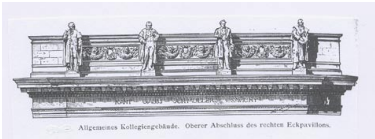
Fig. 5 – Les savants sur la façade du bâtiment collégial, côté sud. Source : Strassburg und seine Bauten .
