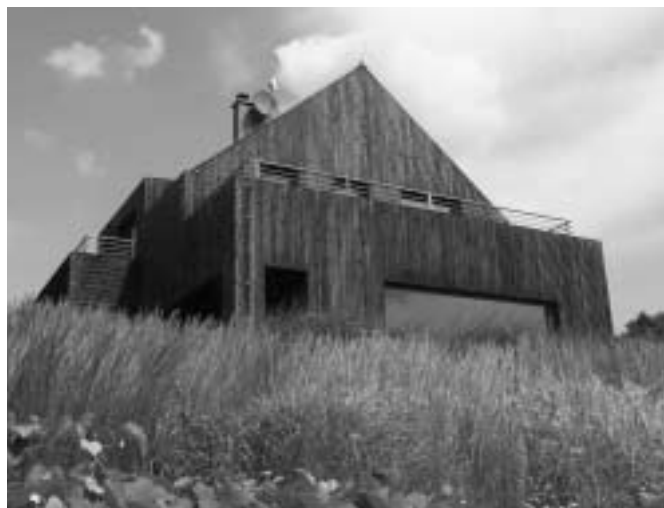
5 Dom w Burowie – elewacja południowa (fot. aut.).
