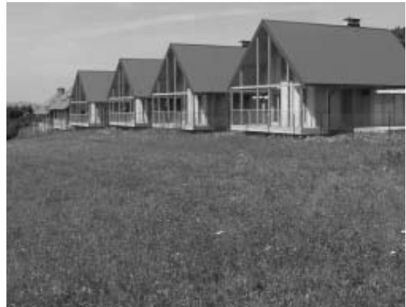
[14] Osiedle Słoneczne Tarasy – elewacje południowe (fot. aut.).
