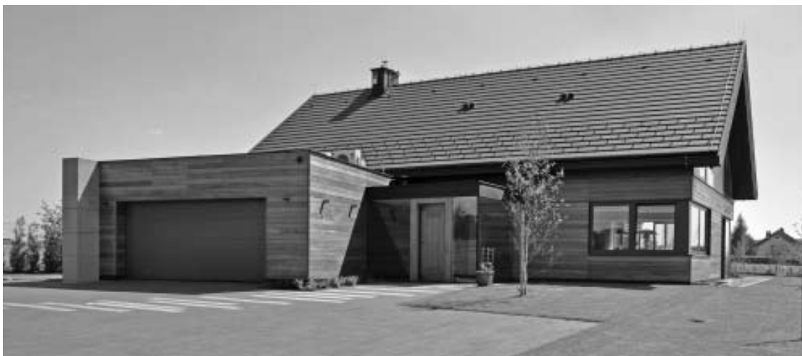
[9] Dom w Zielonkach – widok elewacji północnej (fot. archiwum pracowni Studio S Michał Szymanowski).
