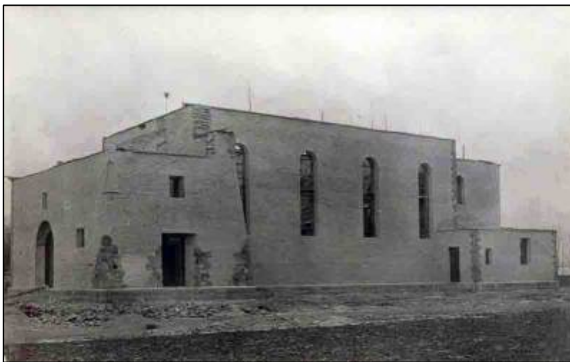
Kościół w Wieleninie w czasie budowy (Fot. Archiwum TPU)
