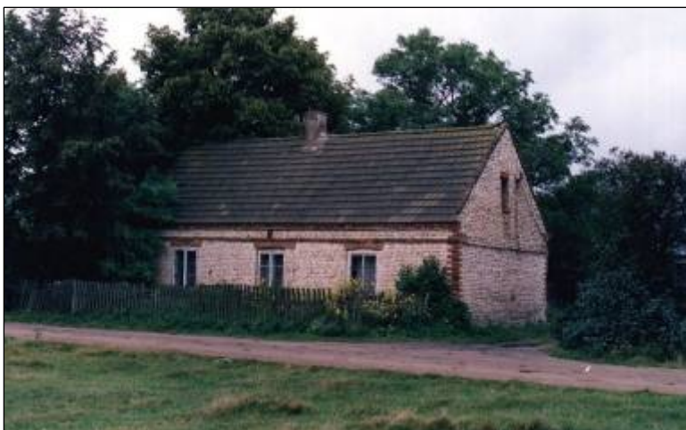
Przed remontem (Fot. archiwum TPZŚ)
