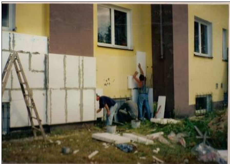
Docieplenie budynku (Fot. Kronika SOSW)
