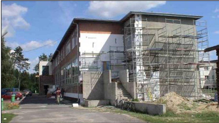
Dobudowa pomieszczeń szkolnych i internackich.(Fot.Piotr Wawrzyniak)
