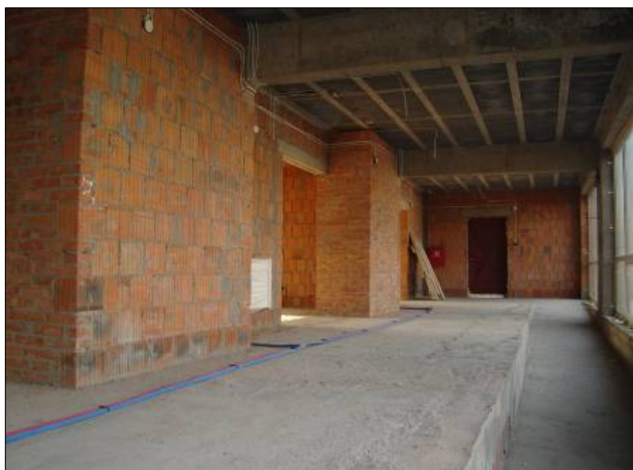
Dobudowa pomieszczeń szkolnych i internackich.(Fot.Piotr Wawrzyniak
