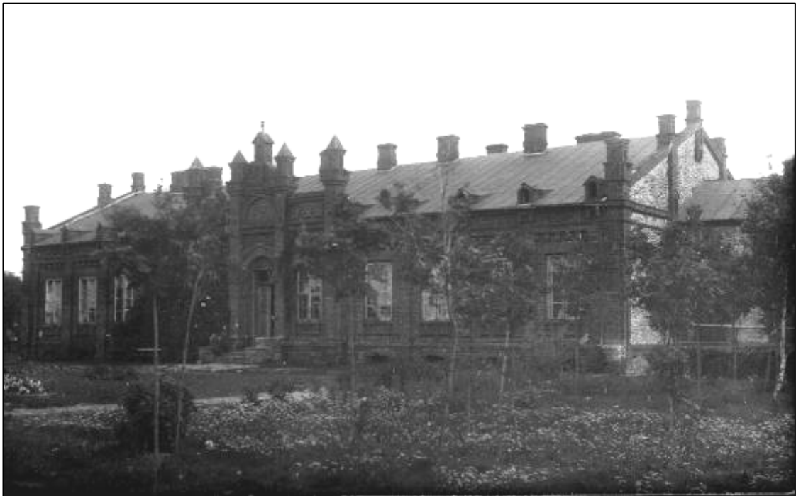
Dworek w Stemplewie wybudowany przez rodzinę Tollów ok. 1914 roku (Fot.archiwum TPU)
