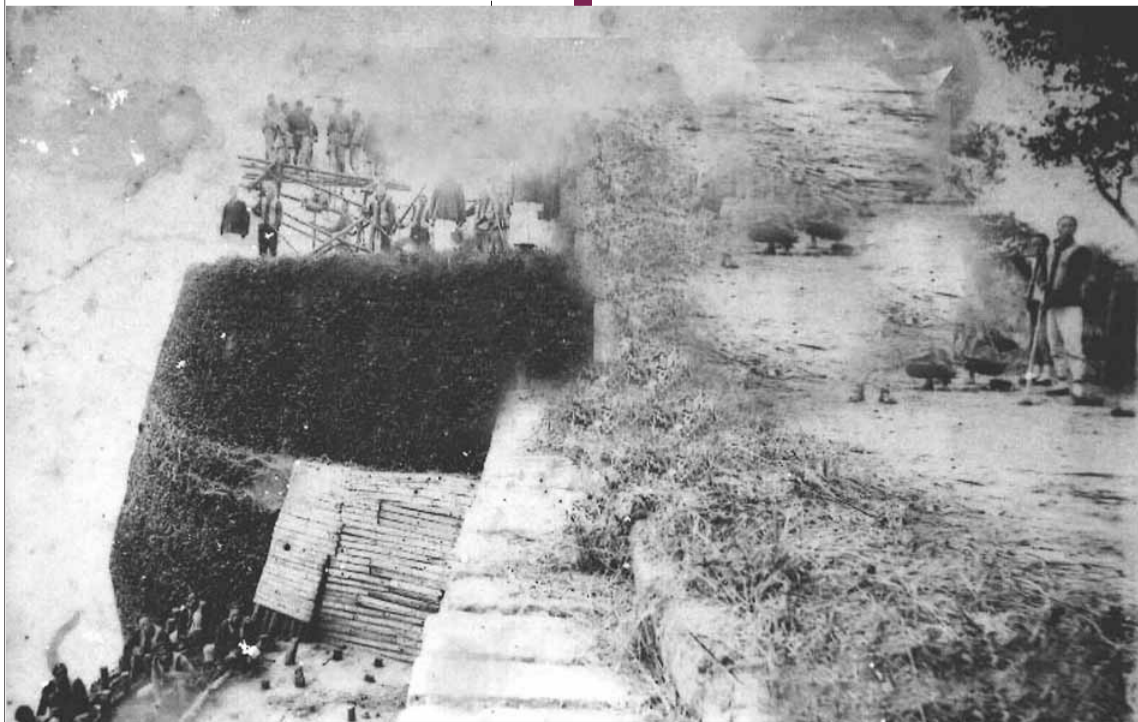
清末宁波民工维修损坏的城墙。
