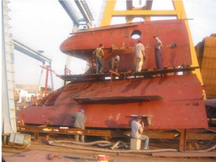
Resim 1.8: Ters olarak inşa edilen blok
