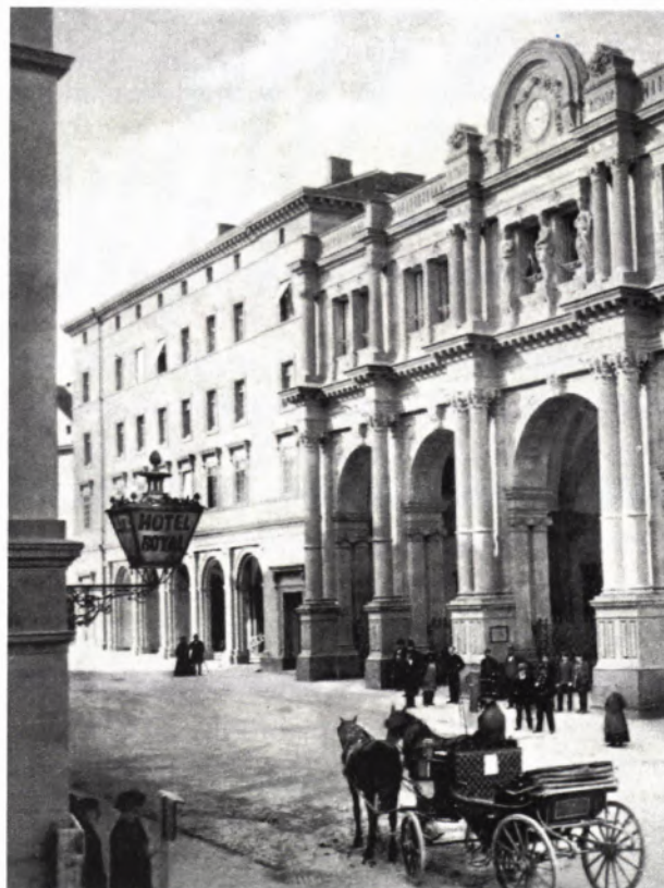
1 DER ALTE STUTTGARTER BAHNHOF mit der Halle von 1864/67 hinter repräsentativer Neurenaissance-Fassade.
