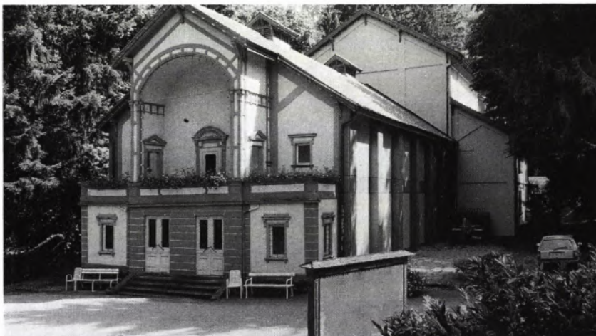
6 ANSICHT des Theaters 1987. Alle folgenden Abbildungen zeigen den baulichen Zustand von 1987.
