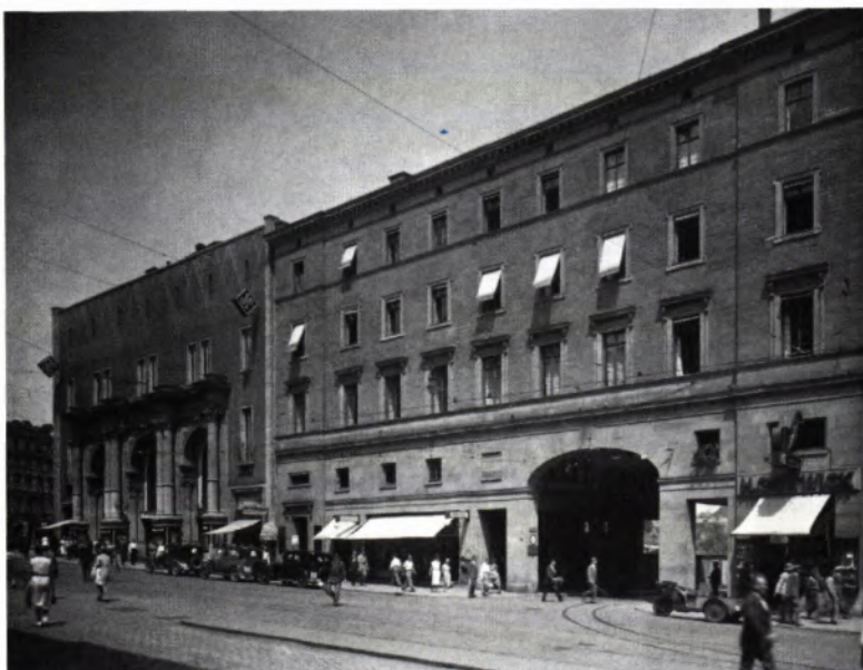
3 DAS EMPFANGSGEBÄUDE des ersten Stuttgarter Bahnhofs nach der Aufstockung (1867) und nach dem Bau des Durchbruchs für die Stephanstraße (1925), links daneben der UFA-Palast. Foto aus der Zeit vor dem Zweiten Weltkrieg.
