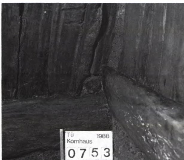
5 DETAILAUFNAHME der Befunde in der Nordwestecke des östlichen Kellers.
