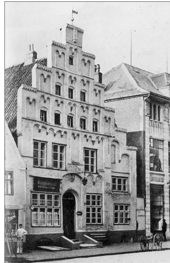
Haus Werner, Großstr., um 1600 erbaut
