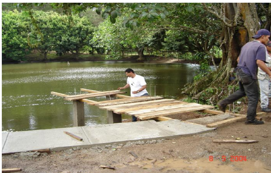
Construcción de andenes y muelle turístico; Laguna Venecia
