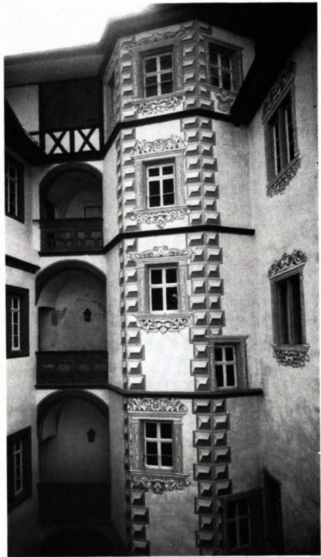
ARCHITEKTURMALEREI IM BURGHOF VON ZWINGENBERG. Wohl um 1600 entstanden, sehr zerstört und nun in gelungener Weise restauriert bzw. ergänzt, gibt die Malerei am Treppenturm (1574, Abb. rechts) und am Palas (Abb. oben) mit ihren ockerfarbenen Diamantquadern und dem reichteiligen Dekor um die Fenster Zeugnis für die optische Bedeutung der Malerei am Bau.
