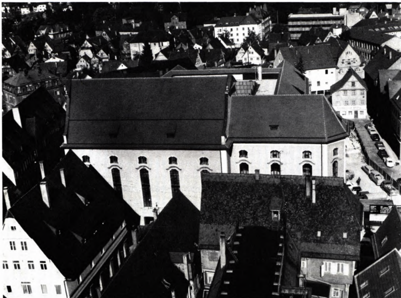
DER PREDIGER IN SCHWÄBISCH GMÜND. Das mächtige, aus Kirche und dreiflügeligem Konventsgebäude sich bildende Geviert des ehemaligen Dominikanerklosters, das hier von Süden her gesehen ist, fügt sich in den Rahmen schmaler Gassen und teilweise noch alter Fachwerkhäuser. Diese beengende Nachbarlichkeit ist kein Zufall oder nur Ergebnis späterer Entwicklung, sondern typisch für den Willen der Dominikaner, ihre Klöster nicht weltabgeschieden zu placieren. Sie siedelten sich mitten in den Städten und hier, wenn möglich, in den Armenvierteln an.
