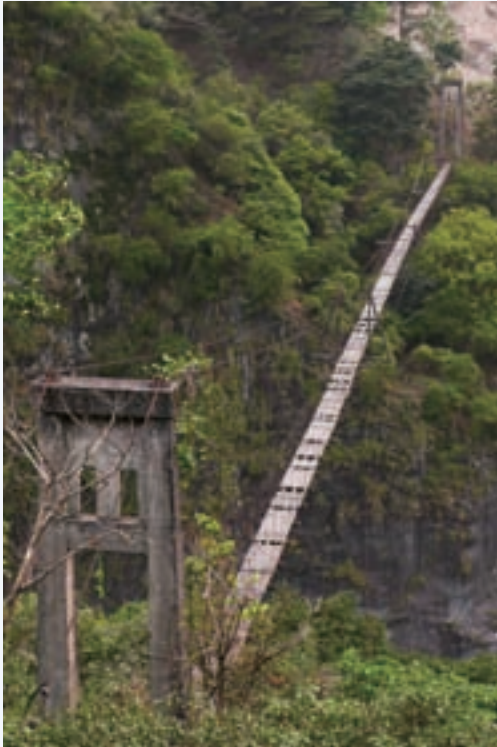
● 舊丹大吊橋位於丹大東溪與丹大西溪匯流處附近，建造於日治時代，目前已廢棄，橋面部分傾斜且木板少數脫落。
