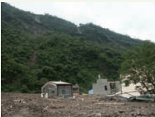
● 96年聖帕颱風造成好茶村落西側的崩塌岩屑，直接衝進二、三十多戶的民宅，使得靠近山邊的部分民宅掩埋高度約有1層樓之高。
