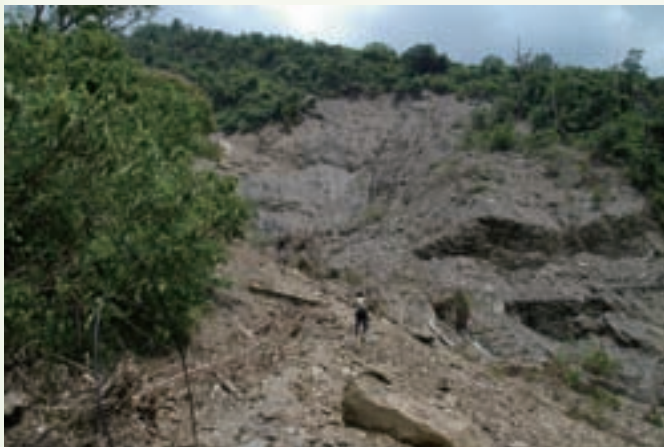
● 土石流03之土石崩塌狀況。
