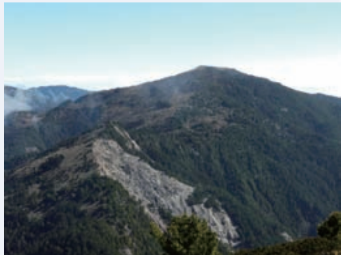
● 出露於義西請馬至山的岩層，以板岩間夾薄層變質砂岩為主，行經義西請馬至山途中，常出現因板岩具有相當發達的板劈理而產生大型崩塌地。
