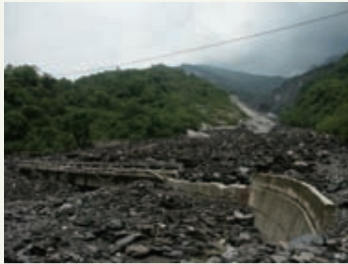
● 編號屏東006的土石流潛勢溪流，因96年聖帕颱風影響再度引發土石流，大量的板岩岩屑將近淹沒河上的橋樑。
