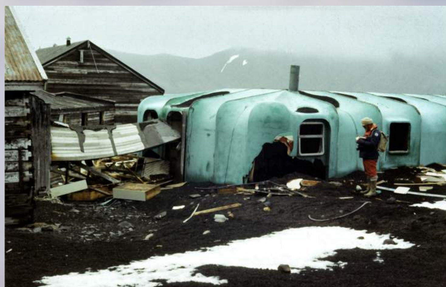
Zniszczone zabudowania polarnej stacji brytyjskiej w kalderze wulkanu Deception
