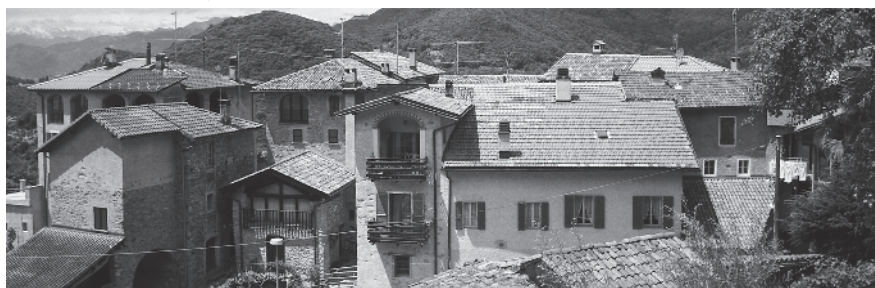
6 Vista dalla cantonale
