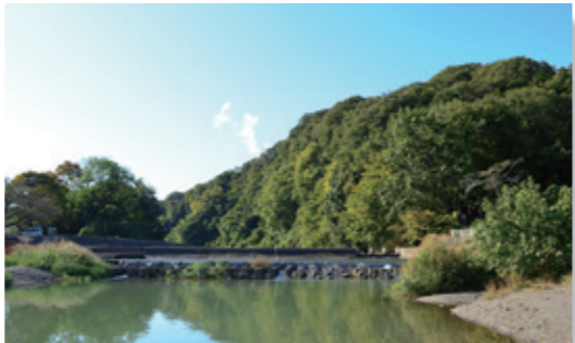
高麗川一号堰 停留所：城山中学校 (おおや線)
