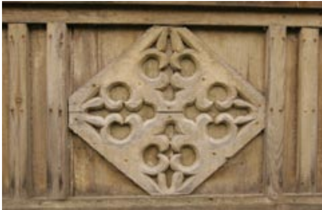
Wycięta dekoracja w budynku nr 36 w Ostaszewie.
