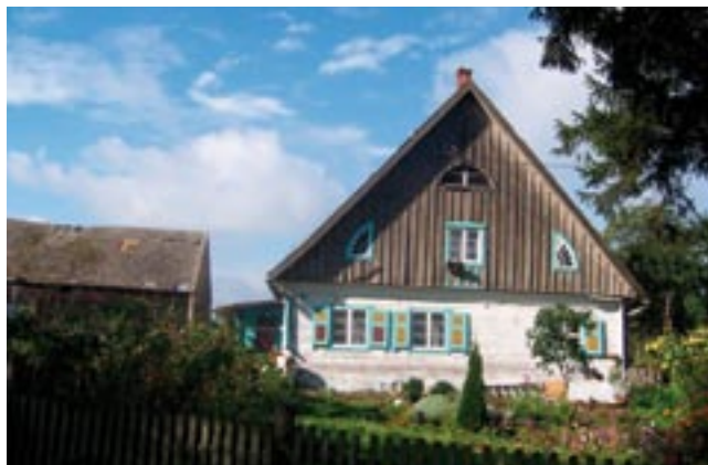
Szczyt dwupoziomowy, 3-osiowy z ćwierćelipsowymi świetlikami, dom nr 23 w Wikowie.
