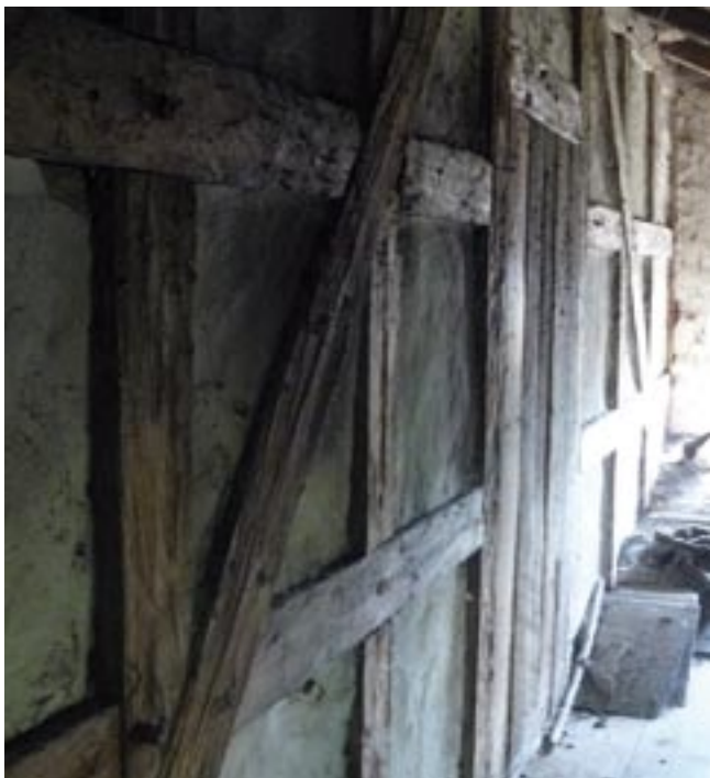
Ściana z muru pruskiego na strychu domu nr 11 w Palczewie.
