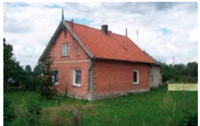
Przykład małego domku o dekoracyjnym zestawieniu ceglanej licówki i otynkowanych obramowań narożników i otworów okiennych naśladowując kamienny detal, budynek w Zwierznie.
