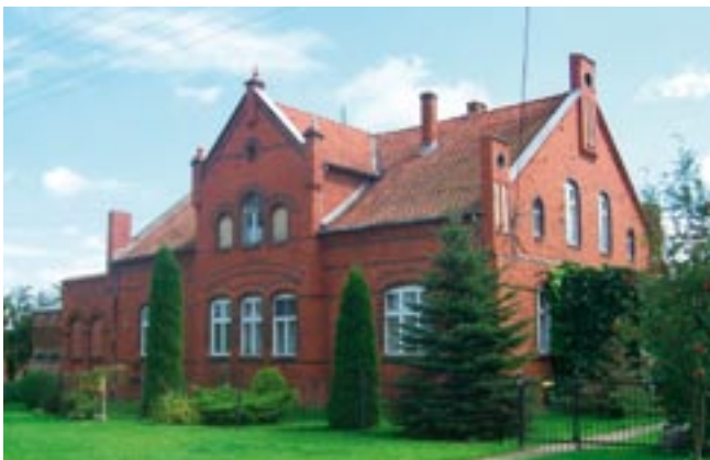
Przykład budynku ceglanoego, 1,5 kondygnacyjowego o elewacjach wyłożonych różnokolorową glazurowaną cegłą, początek XXw. Janówka 35.
