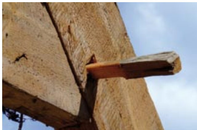
Kolek blokujący czop w drewnianej konstrukcji.
