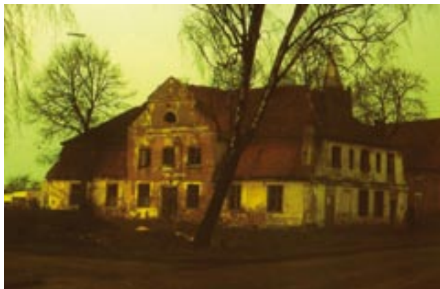
Budynek plebanii w Królewie z XVIII w., rozebrany.
