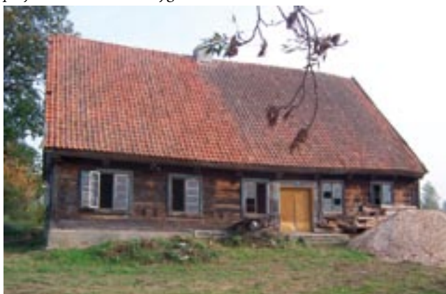
Sześciooosiowa elewacja domu nr 11 w Świerznicy z 1 poł. XIXw., wejście ujęte pełnymi oknami.
