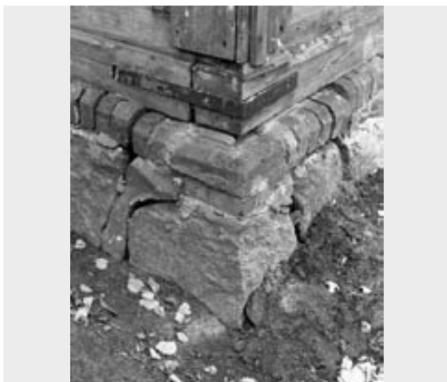
Podmurówka z kamienia, z wyrównującym rzędem cegieł ustawionych wozówkowo, o ściętych narożnikach i z belkami podwali nowymi spiętymi stalowymi klamrami.
