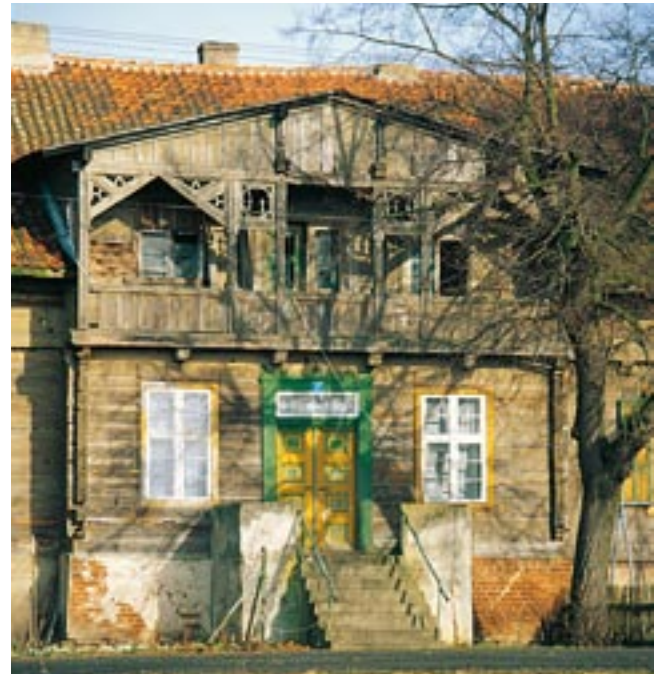
Wysokie, betonowe (wybudowane wtórnie) schody przed domem nr 25 w Pordenowie.
