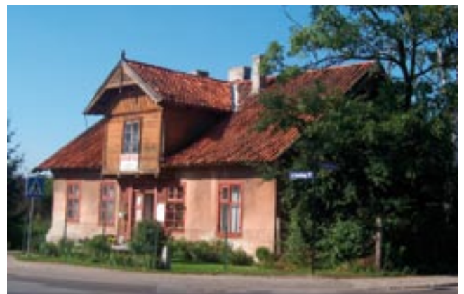
Dom z facjatą nadwieszoną, ul. Katowicka w Cedrach Wielkich.
