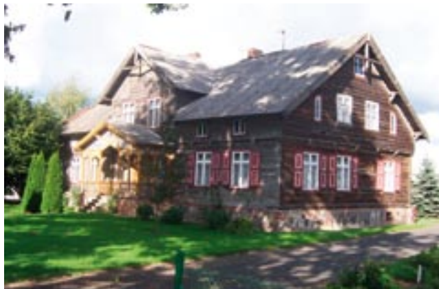
Przykład budynku z nadwieszoną ścianką kolankową, dom nr 8 we Wróblewie.
