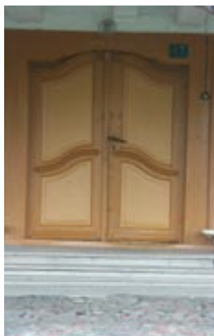
168. Drzwi wejściowe, barokowe w domu podcieniowym nr 17 w Rozgarcie.
