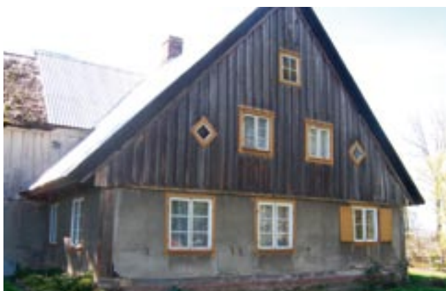
Szczyt z rombowymi świetlikami, dom podcieniowy nr 13 w Markusach.
