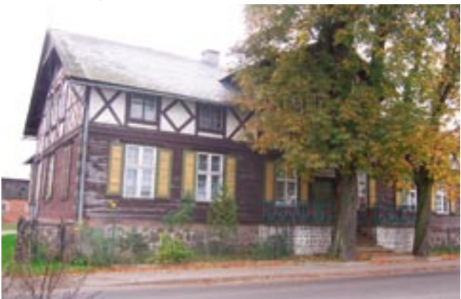
Przykład budynku z zaakcentowaną ryglową konstrukcją ścianki kolankowej, dom nr 37 z 1847 r. w Żuławkach.
