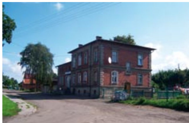
Przykład budynku „kamienicy” o elementach neomanierystycznego kostiumu w opracowaniu elewacji w Pogorzałej Wsi.
