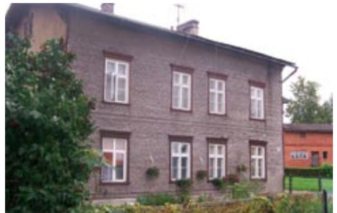
Oszalowanie gontem w łuskę elewacji domu w Nowym Stawie przy ul. Gdańskiej.
