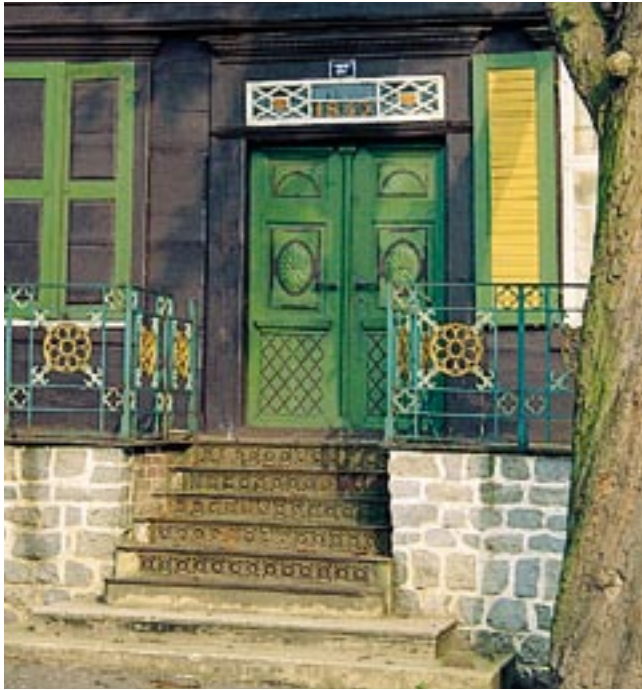
Żeliwne schody zewnętrzne przed domem w Żuławkach.
