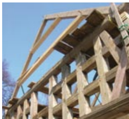
Konstrukcja ryglowa wystawki domu podcieniowego.
