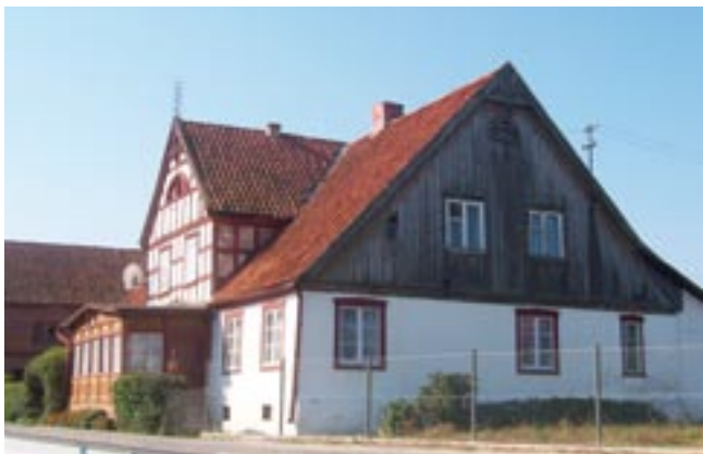
Budynek murowany z oszalowanymi szczytami, ryglową facjatką i bogato dekorowanym gankiem, przykład z Marzęcina.
