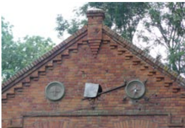
Rozety na szczycie elewacji północnej.
