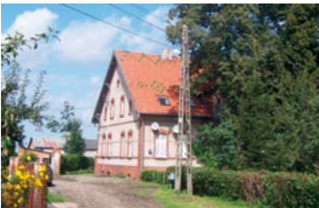
Przykład budynku wyłożonego białą cegłą, z obramieniami okien, drzwi i gzymsów cegłą czerwoną, dom w Kranolęce.
