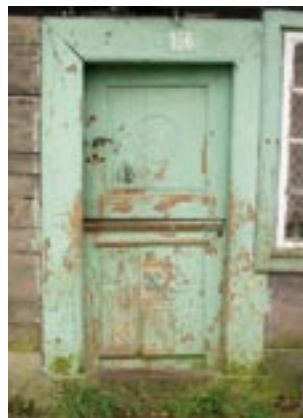
Dekoracyjne, dwoinkowe drzwi w domu w Drewnicy 166.
