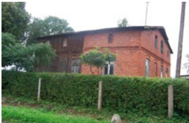
Przykład budynku w części drewnianego, w części murowanego, dawna szkoła w Lubstowie.
