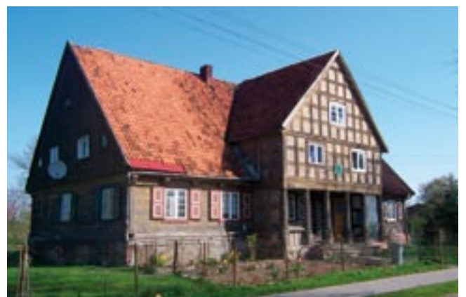
Dom podcieniowy (remontowany w 1864 r.) w Gniazdowie 28, przykład podcienia krótkiego.
