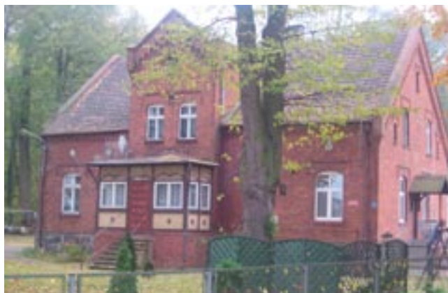
Budynek dawnej pastorówki w Drewnicy.
