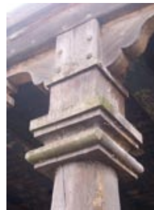
Zwieńczenie słupa podpierającego wystawkę nad podcieniem domu w Żuławkach ukształtowane w głowicę kostkową.
