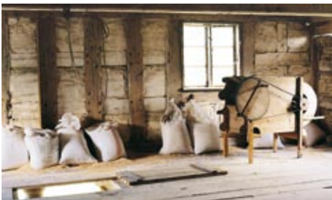
Wnętrze pomieszczenia wystawki nad podcieniem, widoczna konstrukcja, składowane worki oraz kłapa do ich transportowania, przykład z domu podcieniowego nr 29 w Lubieszewie.
