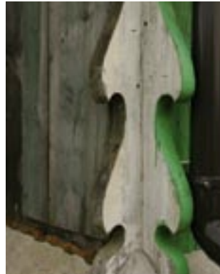
Dekoracja narożników domu w Drewnicy w formie deskowych ostatków wyciętych w fałę.
