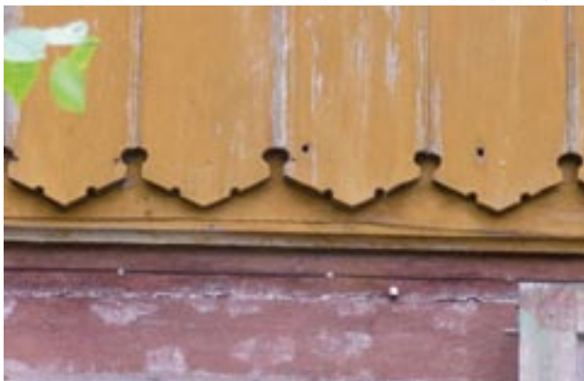
Dekoracyjne wycięcie dolnego zakończenia desek oszacowujących szczyt budynku przykład z domu w Myszewku.
