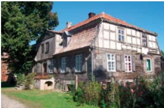
Przykład budynku domu z ryglowymi szczytami i ryglową facjatką w połaci mansardowego dachu, dom nr 2 w Trutnowach.
