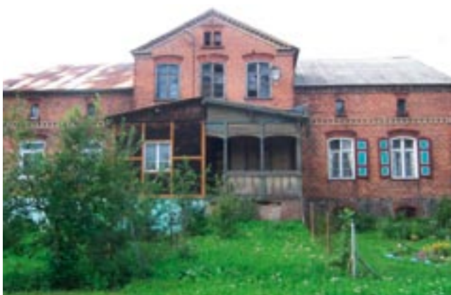
Przykład budynku ceglanoego o bogatym detalu drewnianym w zaciocach konstrukcji okapów dachowych, ganku, dom nr 59 w Gniazdowie.
