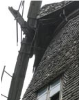
Oszalowanie gontem wyciętym w łuskę, ściana wiatraka w Palczewie.
