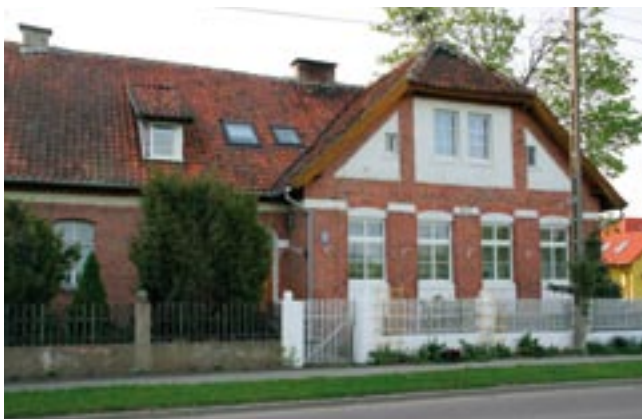
Budynek szkoły w Orłowie.
