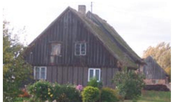
Jednopoziomowy, dwuosiowy szczyt domu w Łaszce.
