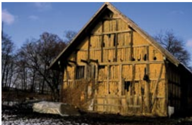
Przykład ryglowej konstrukcji ściany spichlerza w Koźlinach, stan z ok. 1998 r.
