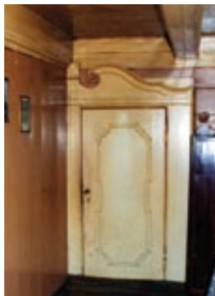
Drzwi w portalu o wklęsło – wypukłym, przerwanym naczółku z domu nr 4 w Przemysławiu.
