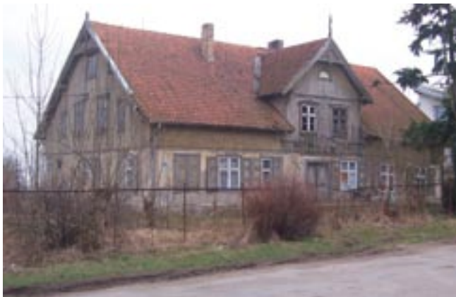
Dom drewniany ze ścianką kolankową i facjatą, przykład ze Zwierz- na 22, dawna gospoda.
