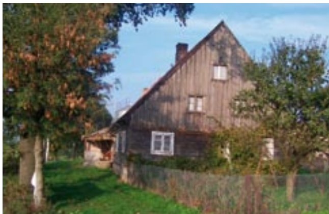
Szczyt dwupoziomowy, na dole 4 osiowy ( ćwierćkoliste świetliki zamarkowane), dom nr 22 w Rakowiskach.
