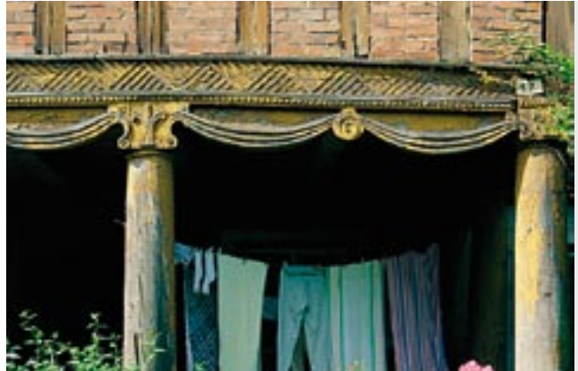
Nawiązanie do kompozytowego porządku w dekoracji głowic słupów domu podcieniowego w Steblewie.
