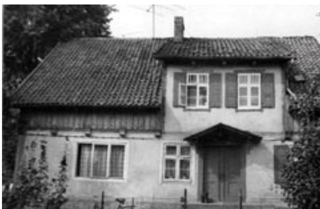
Dom z facjatą pulpitową, przykład budynku nr 5 z Władysławowa.
