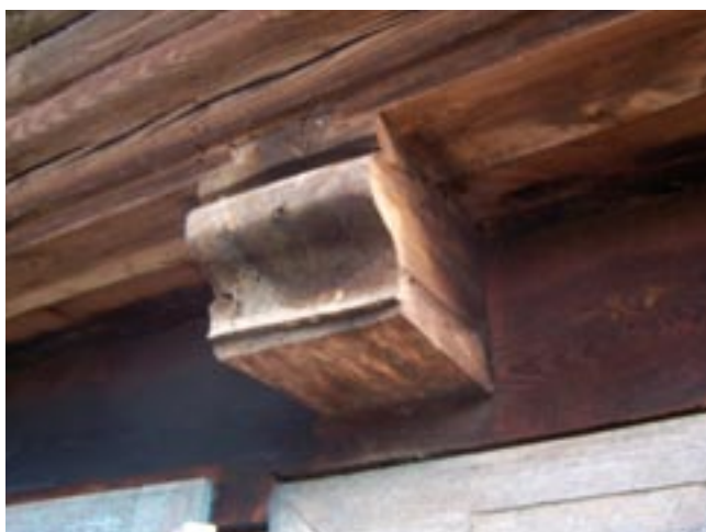
Bogato profilowany zacios belki stropowej i powierzchni belki oczepowej.
