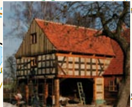
Rekonstrukcja domu podcieniowego w Żelichowie Cyganku
