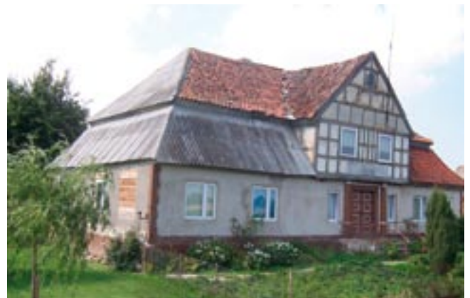
Przykład budynku murowanego z ryglową facjatą podpartą kolumnami, Lędowo 26.
