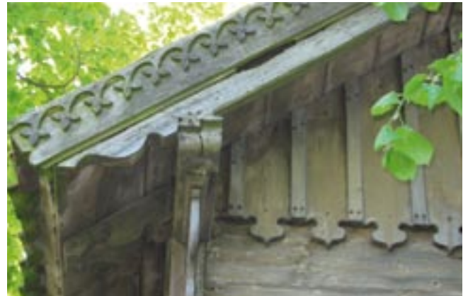
Dekoracyjne wycięcie dolnego zakończenia desek oszacowujących szczyt budynku, przykład z Lubieszewa – kolonii.
