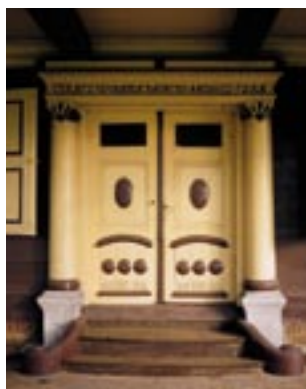
Drzwi w domu podcieniowym w Orłowie.
