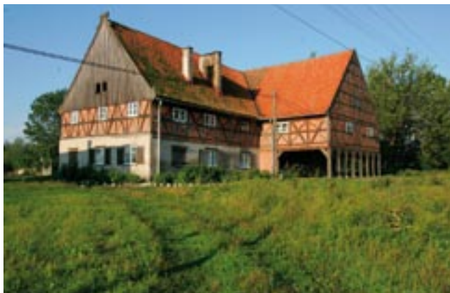
Dom podcieniowy o murowanym parterze, ryglowym piętrze i podcieniu z Miłocina.
