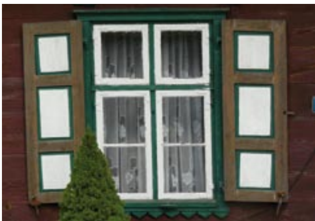
Okno z podziałem na 6 kwater z zewnętrznymi okuciami.
