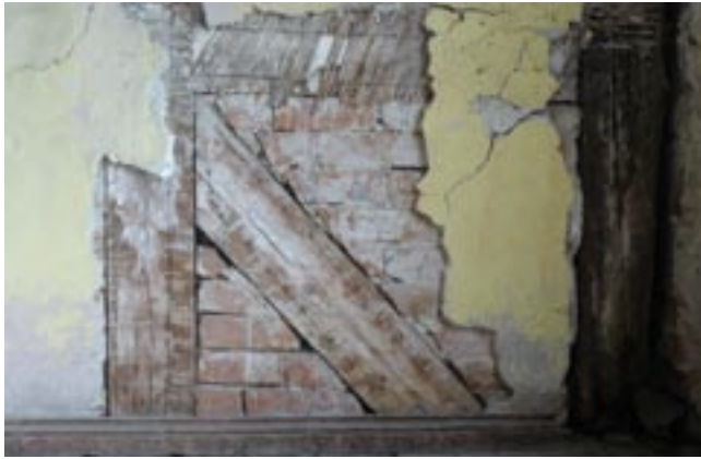
Ceglane wypełnienie rygla, otynkowane, przykład z domu w Palczewie.
