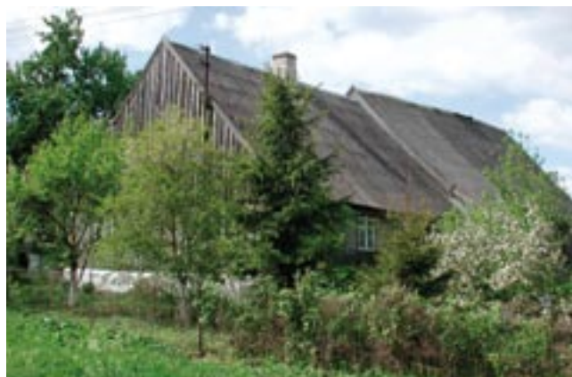
Zróżnicowanie wielkości budynków, przykład zagrody w Krzewsku.
