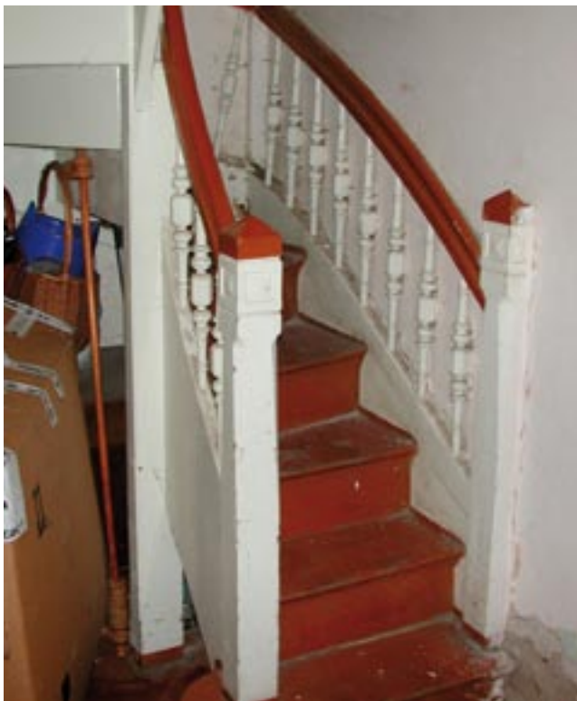
Schody na poddasze w budynku nr 36 w Kępnie.
