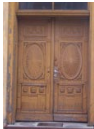
Dekoracyjne drzwi wejściowe z płaskorzeźbioną dekoracją w kamieniczce w Nowym Stawie.
