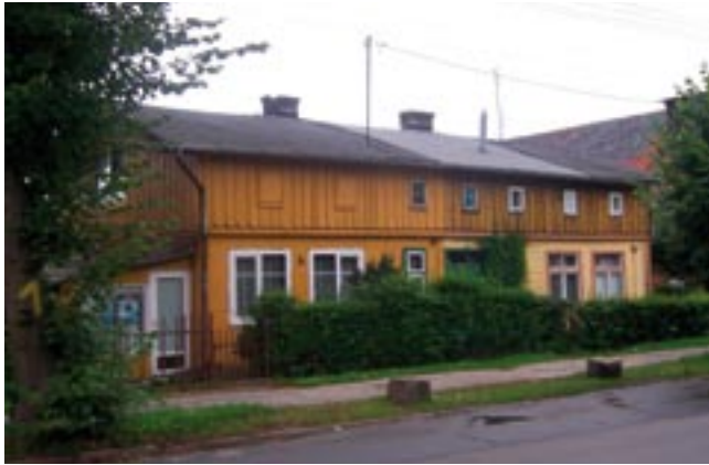
Przykład budynku o wysokiej ścinie kolankowej, budynek nr 7 przy ul. Tczewskiej w Kaldowie
