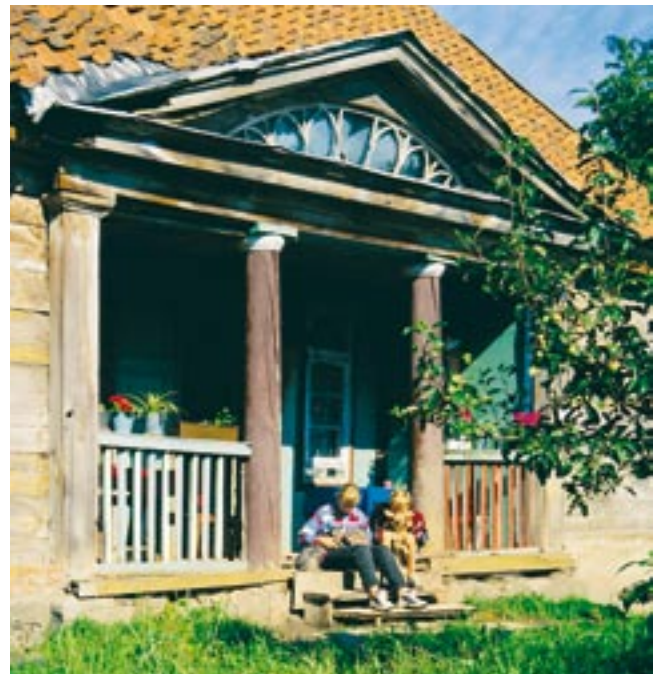
Podcień wgłębny budynku w Wikowie.
