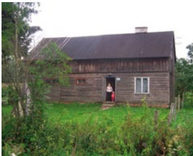
Przykład budynku typowego projektu dla zabudowy całej miejscowości, Cieplice 28.
