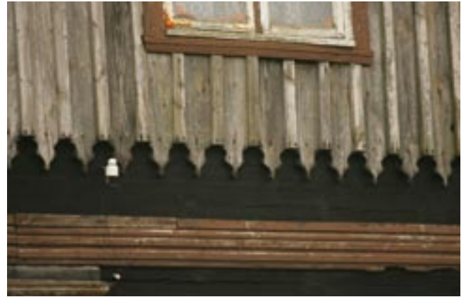
Dekoracyjne wycięcie dolnego zakończenia desek oszacowujących szczyt budynku.
