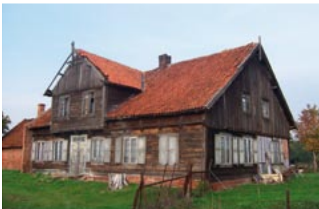
Dom z facjatą nadwieszoną, przykład budynku nr 48 w Drewnicy.
