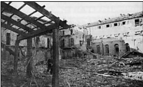
◦ Novi Ligure: Devastazione allo scalo ferroviario di San Bovo.
