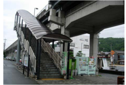
写真：高架ホームへの階段（子守唄の里高屋駅）
