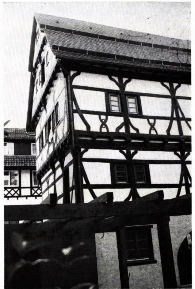
ZUSTAND DER SÜDOSTWÄRTIGEN PARTIE DES PFERDESTALLES VOR UND NACH DER RENOVIERUNG. Der Unterschied spricht für sich selbst. Man beachte die durch die Freilegung des Fachwerks gewonnene Bereicherung der vormals verputzten Giebelwand vor allem auch im Hinblick auf die Durchfensterung. Auf dem Foto rechts ist unten im steinernen Sockelgeschoß gerade noch das rundbogige Tor zu sehen, das mit seinem gegenüberliegenden Pendant (vgl. Abbildung nebenstehende Seite) das Durchqueren des Gebäudes mit dem Wagen oder zu Pferd erlaubte.
