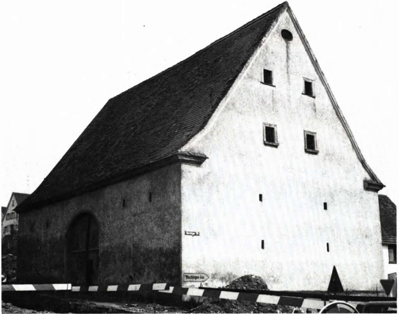
DIE EHEMALIGE ZEHNTSCHEUER IN SCHEER. Der in seiner Großformatigkeit und schlichten Gliederung imponierende spätbarocke Bau war 1973 gegen den Widerstand des Denkmalamtes dem Straßenbau zu opfern. Er gehört in den Reigen der sich leider ständig vermehrenden Baudenkmale, die ihres ursprünglichen Zweckes verlustig gegangen sind und sich nur unter größten Schwierigkeiten einer neuen Verwendung zuführen lassen. Von solcher Art, mußte das Bauwerk trotz seines Wertes gegen die Gewichtigkeit der verkehrstechnischen Erfordernisse unterliegen.
