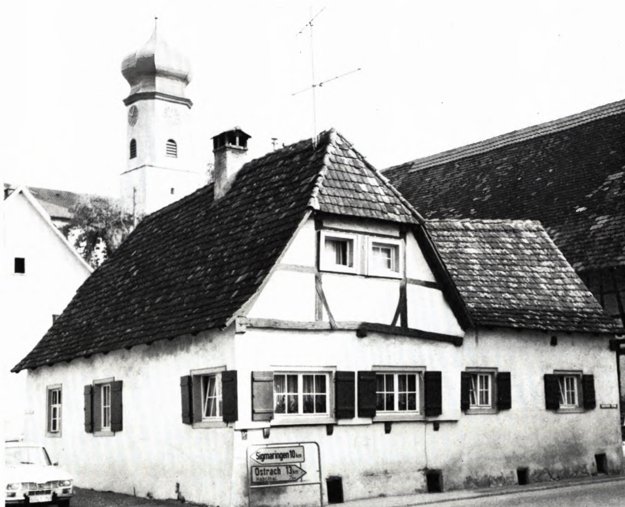
FACHWERKGEBÄUDE Nr. 70 IN KRAUCHENWIES. Das bescheidene Anwesen, das etwa die untere Grenze dessen bezeichnet, was der Denkmalpfleger als erhaltenswertes Kulturdenkmal zu bewerten hat, wurde 1973 zu einem der vielen „Verkehrsofener“, welche die Denkmalpflege in unserem Land verzeichnen muß.
