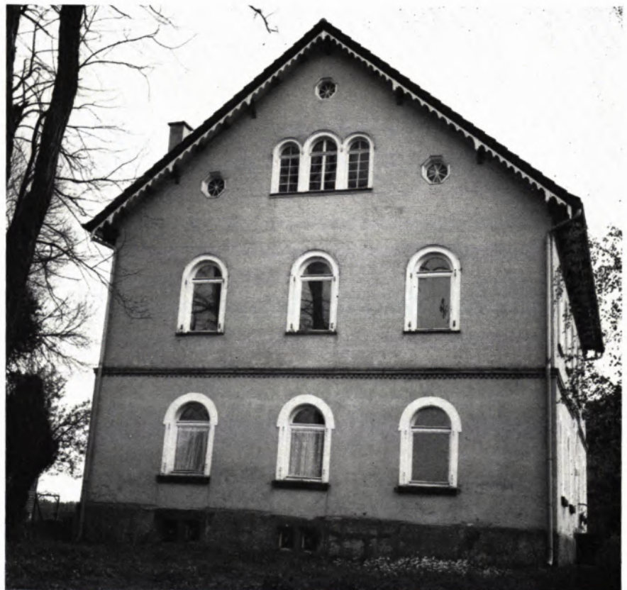
DAS PFARRHAUS IN BÖSINGEN. Der recht gut erhaltene, wohlproportionierte Bau von 1858, ein typischer Vertreter des um diese Zeit gepflegten, aus dem Spätklassizismus hervorgegangenen „Rundbogenstils“, mußte 1972 nach dem Scheitern aller auf seine Erhaltung zielenden Bemühungen des Landesdenkmalamtes zum Abbruch freigegeben werden.
