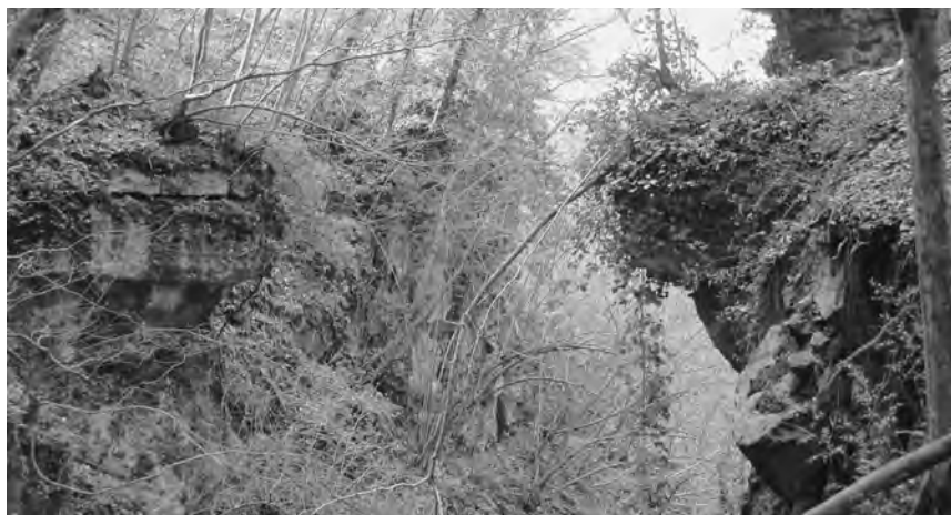
FIG. 29. Bolsena. Resti del ponte romano su Fosso della Paura (Fosso Brutto) del percorso Cassia-Traiana.
