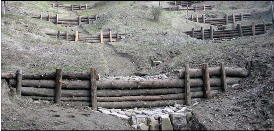
**Foto 4 e 5.** Esempi di sistemazioni anti-erosione con l'uso di materiale recuperato in loco (fonte Parco Gallipoli Cognato Piccole Dolomiti Lucane – Basilicata)
