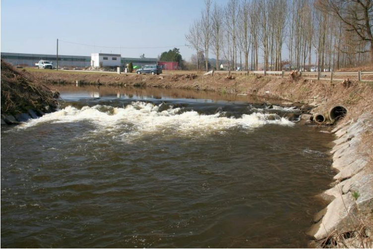
Abb. 23 Für Kleinfischarten und Neunaugen unpassierbare Rampe bei Aisting vor dem Umbau.
