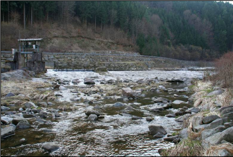
Abb. 12 Gefällereiche Ausleitungsstrecke zur Energiegewinnung in der Aist nördlich des Josefstals.
