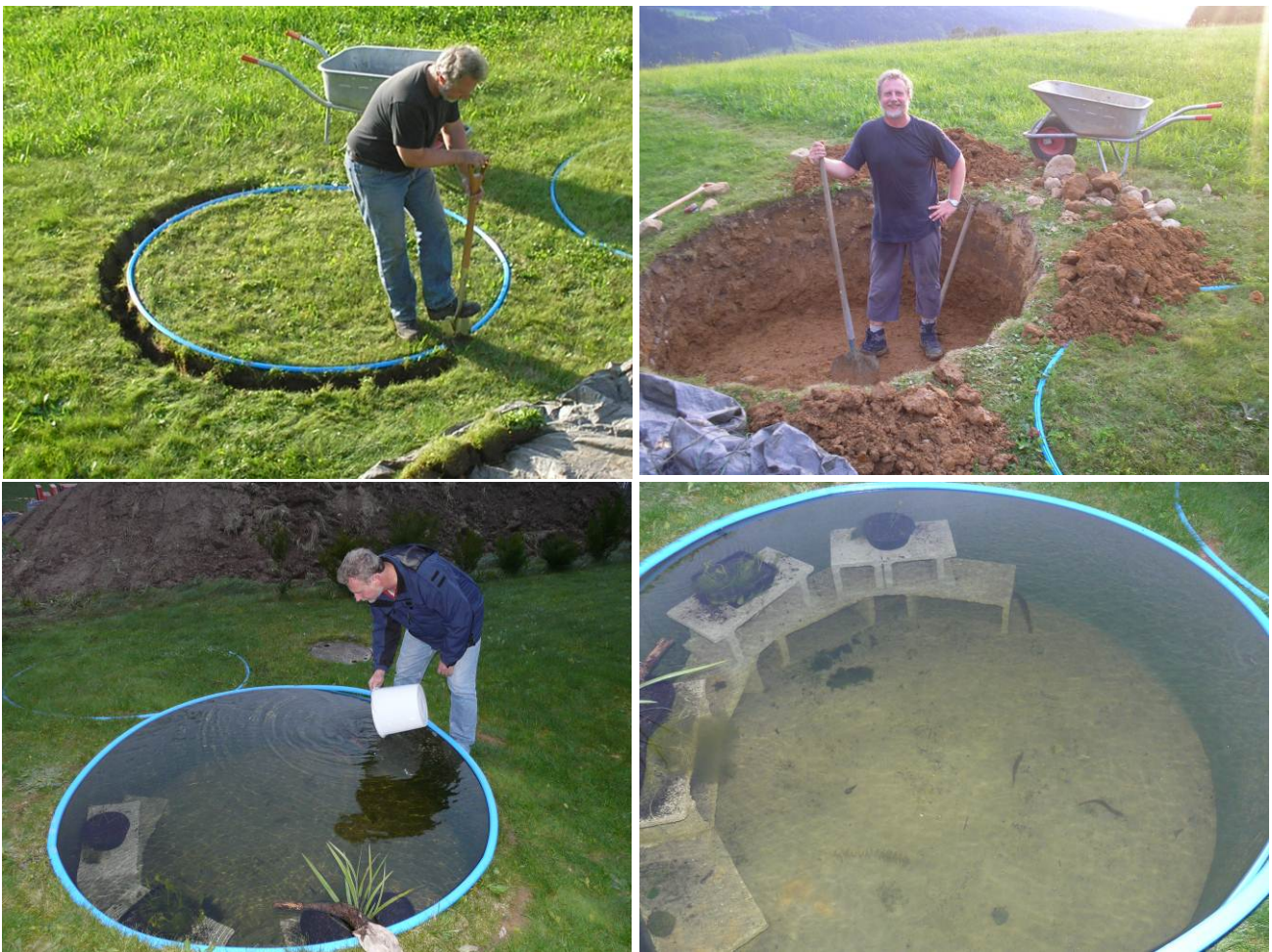
Abb. 35 Installation der Rundbecken zur Haltung der Schlammpeitzger in St. Lorenz am Mondsee
