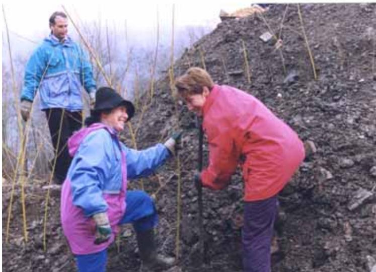
Mit einem Eisenstab wird vorgelocht, um den Weiden-Steckling gut in der Erde zu verankern.
