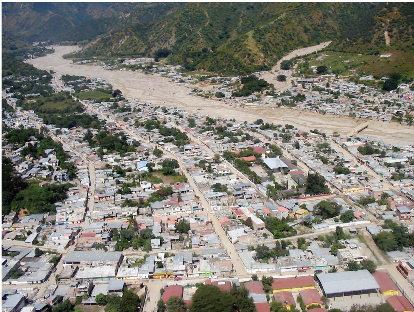
Inundación por el paso del huracán Stan en Tapachula/CENAPRED
