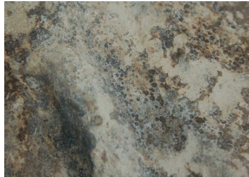
Alterazione biologica: crescita di microrganismi sulla superficie già interessata da fenomeni di erosione.
