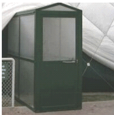
Obr.8) Vstupní komora
