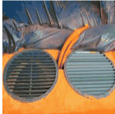
Obr.11) Přívod vzduchu z nadzemního plechového potrubí
