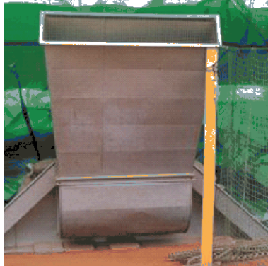
Obr.11) Přívod vzduchu z nadzemního plechového potrubí
