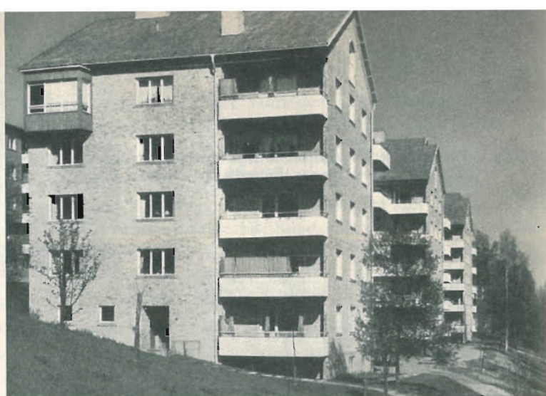
Tre av AB Hyresbostäders hus i kv. Eldaren, ritade av arkitekt SAR Nils Grafström och uppförda 1948—50 i gult sandat Röbo-tegel av Byggnads AB Hallström & Nisses.
