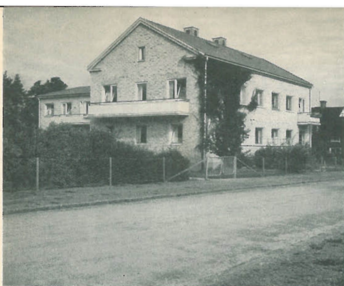
Frälsningsarméns Barnhem, ritat av ing. Hans Åke Bengtsson och uppfört av Byggnadsfirman Bäckström & Strömberg, Umeå, år 1947. Gult chamotterat Röbo-tegel.
