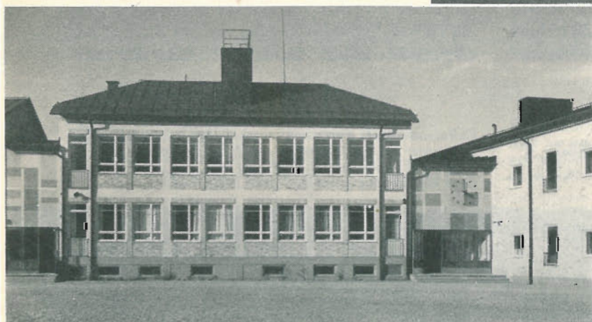
Sankt Olofsskolan, 1954—56. Arkitekt SAR Gunnar Lené. Byggnadsfirma J. E. Bäckström & Co. Gult chamotterat Brogårdstegel.
