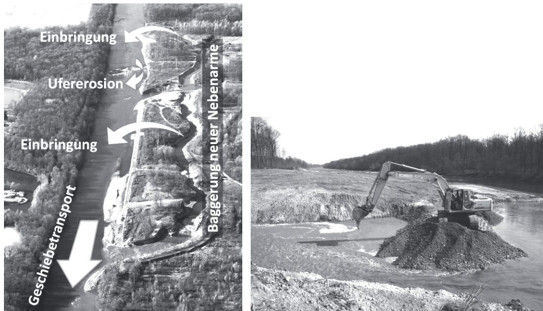
Abb. 1: links: Funktion der Maßnahme an der Grenzmur, rechts: Öffnung des Nebenarms.
