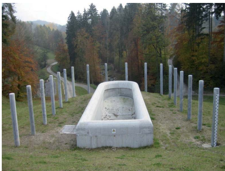
Abb. 8: Hochwasserentlastung mit vorgelagertem Schwemmholzrechen.
