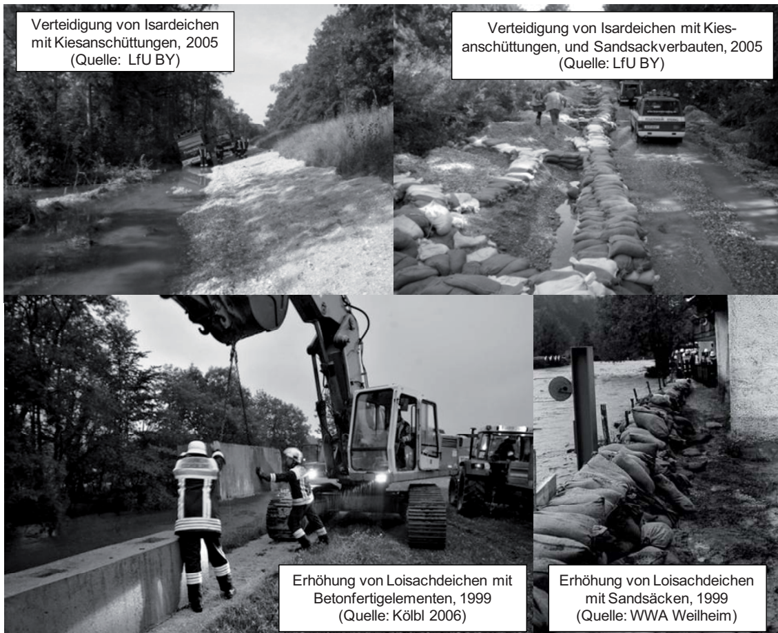
Abb. 9: Beispiele von Deichverteidigungsmaßnahmen (unterschiedliche Quellen).
