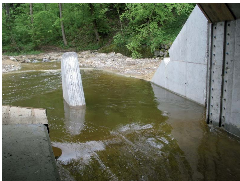
Abb. 4: Einlaufbereich zum Durchlass im Bauzustand ohne Frontplatte und Drosselblende.
