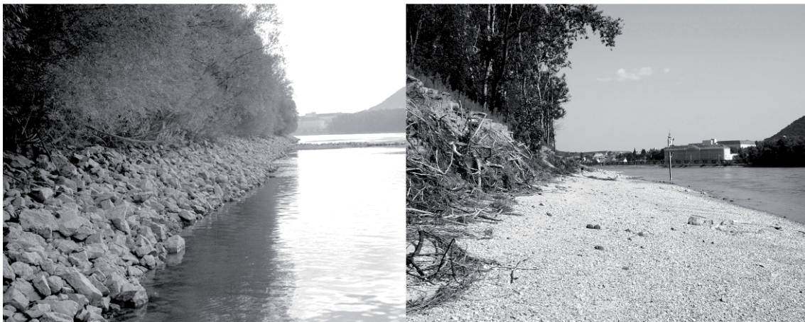
Abb. 4: links: Ufer bei Strom-km 1885 (knapp stromauf) vor dem Rückbau, rechts: Ufer bei Strom-km 1885 (knapp stromab) nach Rückbau (etwa ein halbes Jahr nach dem Bauende).
