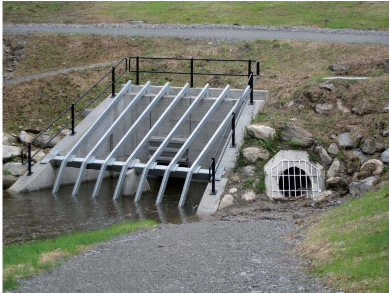
Abb. 7: Einlaufbauwerk mit Drosselöffnung und Tauchrechen sowie seitlicher Notentleerung.
