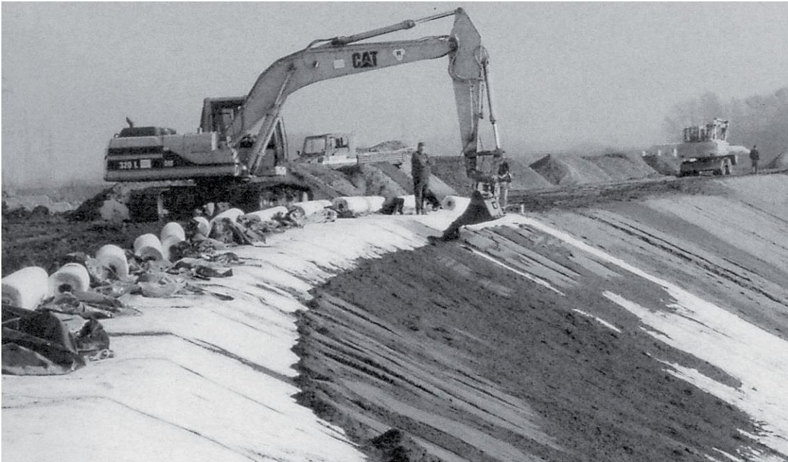
Abb. 2: Lippedeich-Sanierung (1994): Einbau der GTD Bentofix® als Deichdichtung (Saathoff et al 2003).
