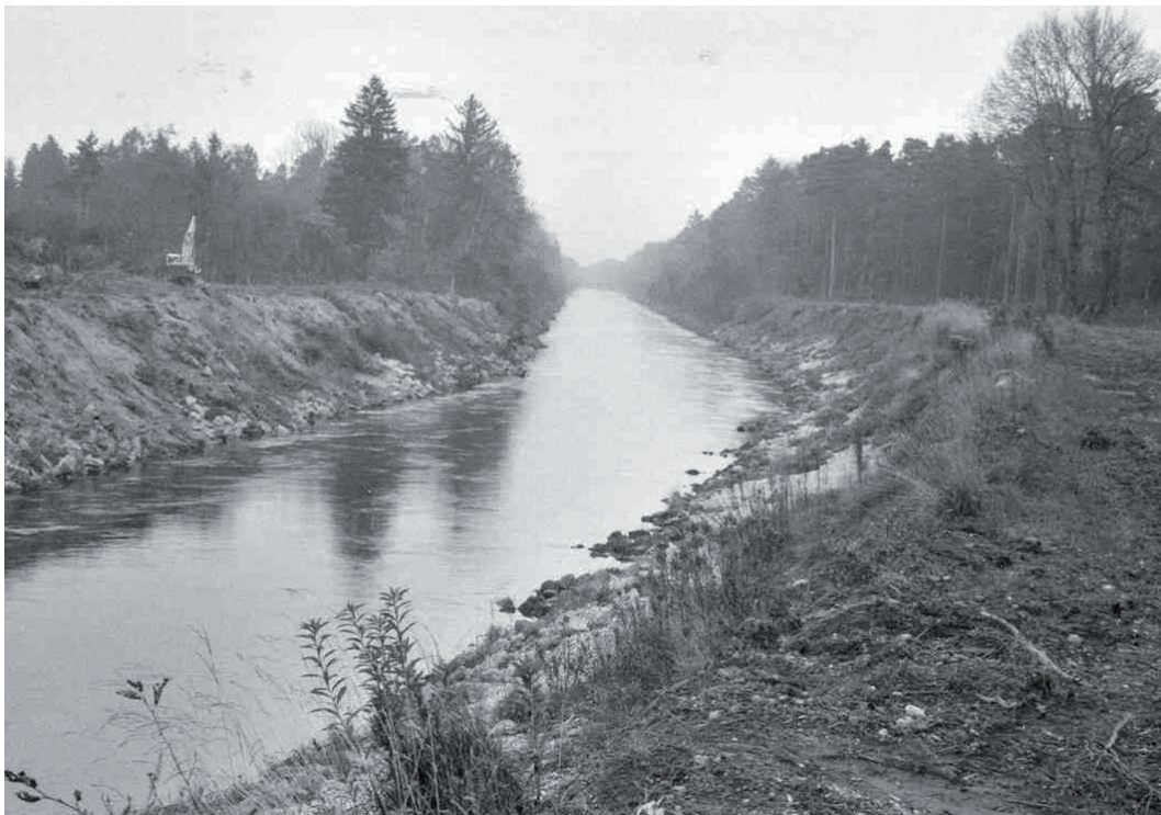
Abb. 3: Wertach bei Fkm 13,0 (unterstrom Staustufe Inningen) vor Baubeginn.
