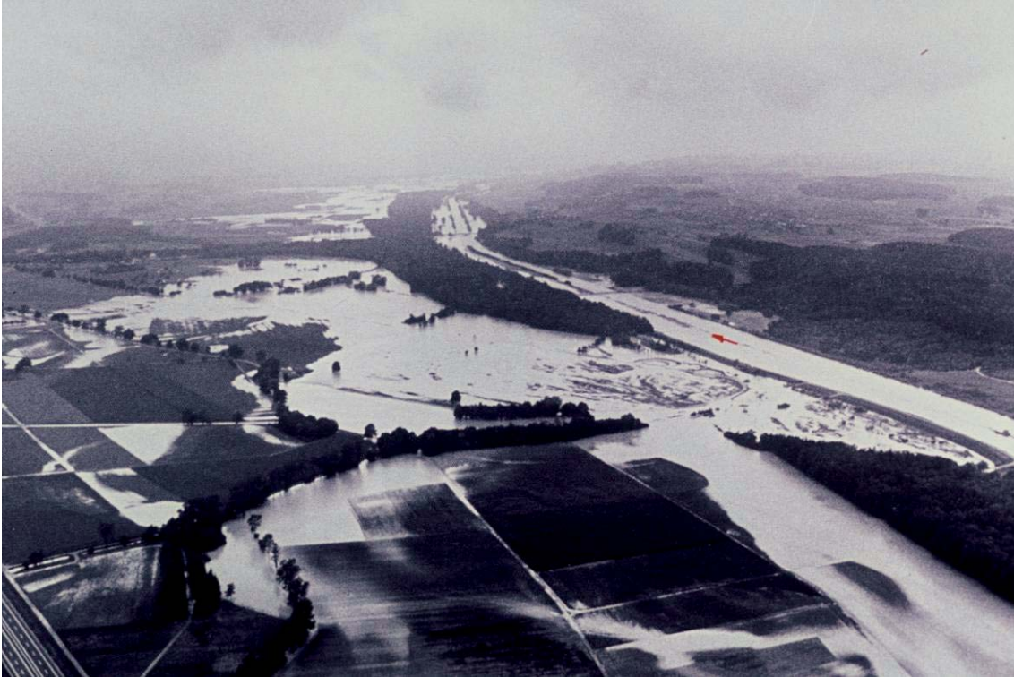
Abb. 1: So darf das Thurtal nicht mehr aussehen. Dammbrech Frauenfelder Allmend 1978, Blickrichtung Thurtal abwärts, rechter Bildrand die Thur.
