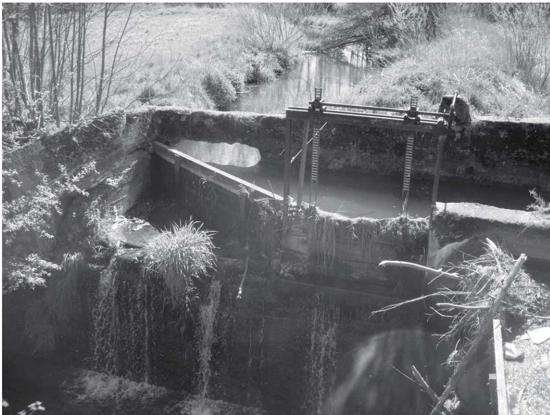
Abb. 1: Sanierungsbedürftige Wehranlage.
