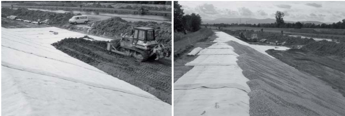
Abb. 3: Kindzigdeich-Sanierung (2001): Überschütten der GTD Bentofix® mit Aufbringen des örtlich vorhandenen Kiessandes als "wühltierunfreundliche" Deckschicht (rechts).
