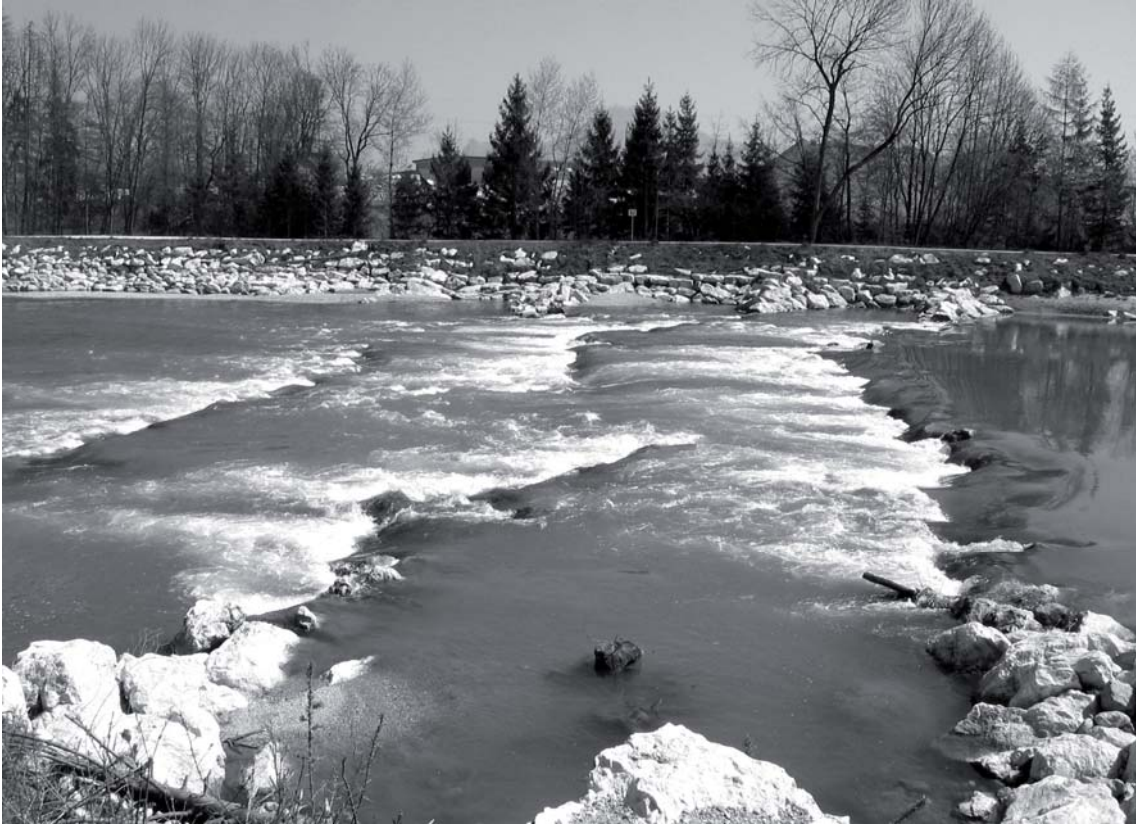
Abb. 4: Die Saalach-Rampe bei Feldkirchen als Beispiel für eine aufgelöste Sohlabstufung.
