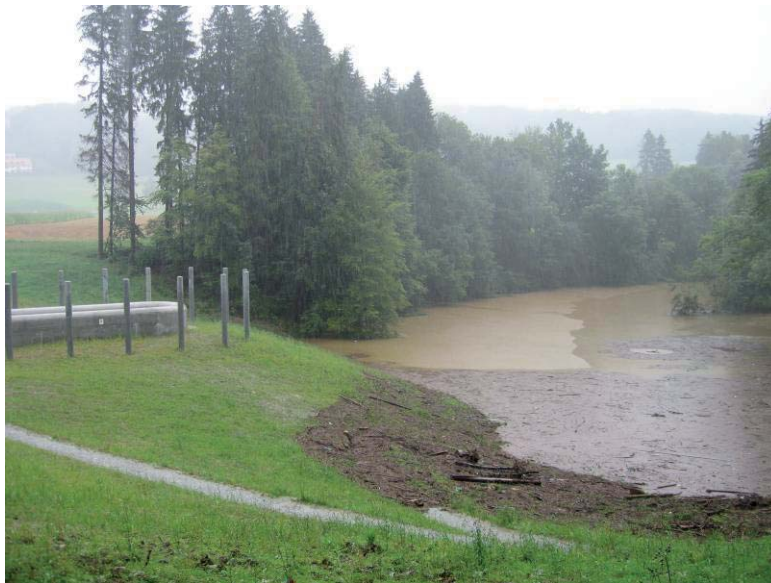
Abb. 10: Ersteinstau des Hochwasserrückhaltebeckens am 9. August 2007.
