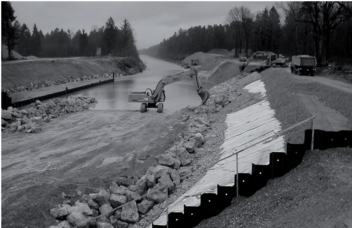
Abb. 6: Bau der Rauen Rampe Fkm 13,0.
