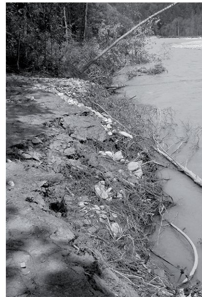
Abb. 3: Ufer vor und nach der Renaturierung. Links: auf grossen Strecken mit Buhnen verbautetes Ufer. Das Flussbett liegt weit unterhalb des Vorlandes (2003). Rechts: Ufererosion im Frühsommer 2007, frische Sandablagerungen weisen auf eine Überflutung der Aue hin.
