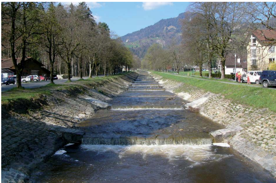
Abb. 1: Kleine Schliere in Alpnach-Dorf: Sperrentreppen mit gepflästerten Böschungen.
