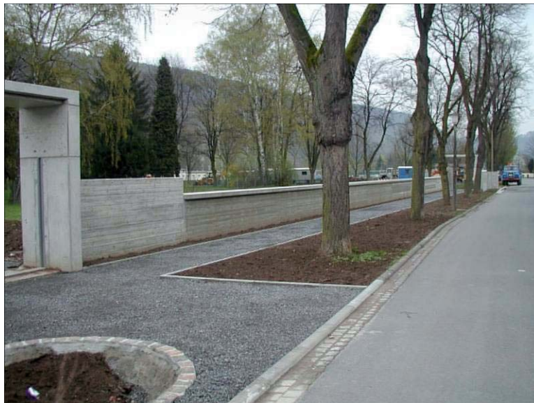
Abb. 3: Überlaufstrecke in HW Schutzmauer Würth/Main.
