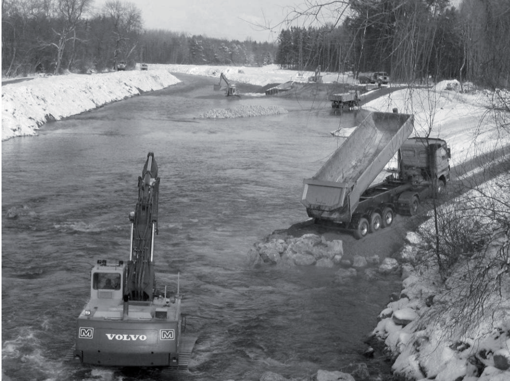
Abb. 7: Einbau Offenes Deckwerk mit Hydraulikbagger.
