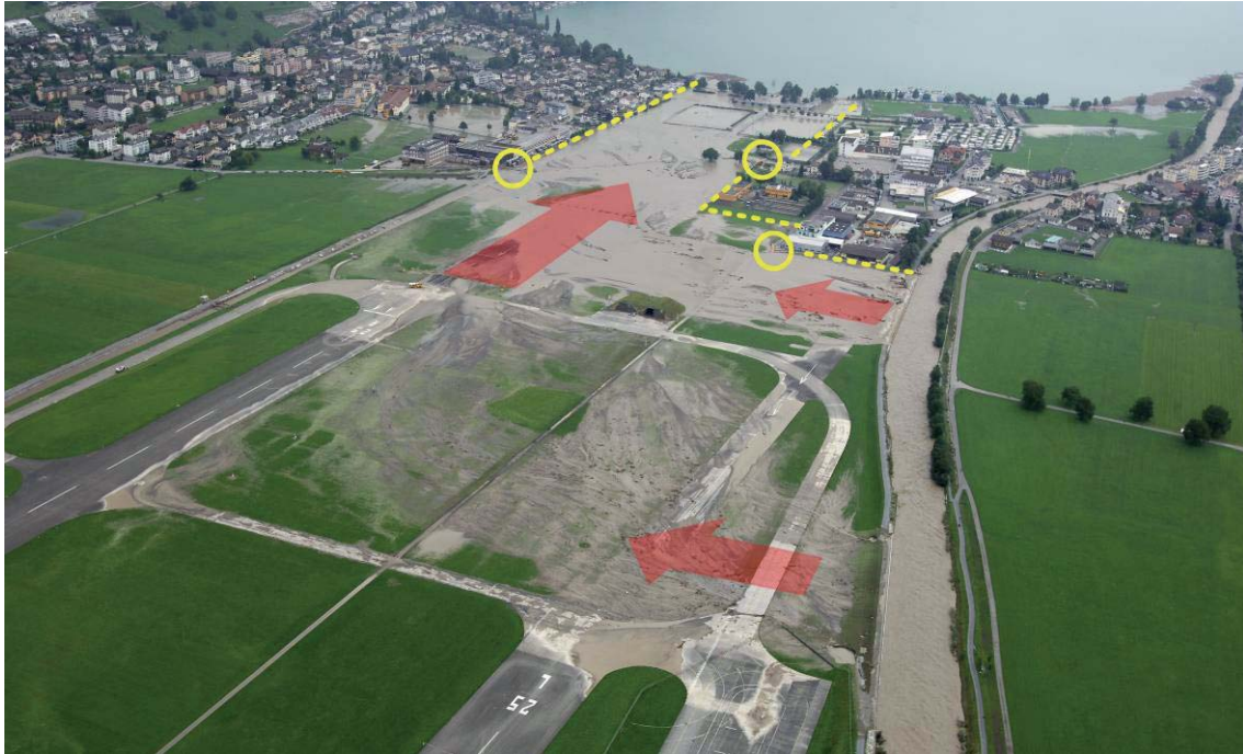
Abb. 5: Stanser Boden am 24. August 2005: Über die beiden Entlastungen beim Flugplatz Buochs wird ein Teil des Abflusses der Engelberger Aa in den Entlastungskorridor abgeleitet. Dämme und Objektschutzmassnahmen (gestrichelte Linien) sowie mobile Massnahmen (Kreise) begrenzen den Korridor (Foto: Schweizer Luftwaffe).
