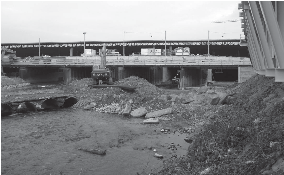
Abb. 4: Situation oberstrom der Durchlässe am Hauptbahnhof während vorbereitender Bau-phase C1 im Februar 2008 (von links nach rechts die 5 Durchlässe A, B, C, D und E unter dem Hauptbahnhof Zürich): Die Durchlässe A und B sind betoniert. Oberstrom Durchlass A werden Uferschutzarbeiten ausgeführt, der Durchlass A ist daher trocken gelegt und der Abfluss von Sihl und Schanzengraben wird durch Durchlass B abgeführt. In den Durchlässen C und D ist die Sohlenabsenkung um 0.6 m ausgeführt und die bevorstehende Betonierung der Sohle wird vorbereitet. In Durchlass E ist die Sohlenbetonierung kurz vor Abschluss.
