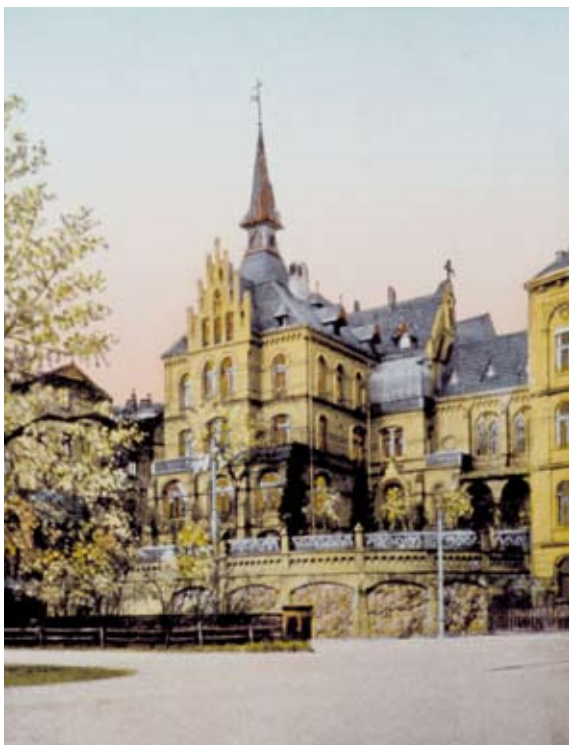
Elisabeth-Krankenhaus in Kassel (beim Bombenangriff am 22. Oktober 1943 zerstört).
