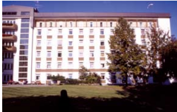
Neubau des Elisabeth-Krankenhauses in Kassel.
