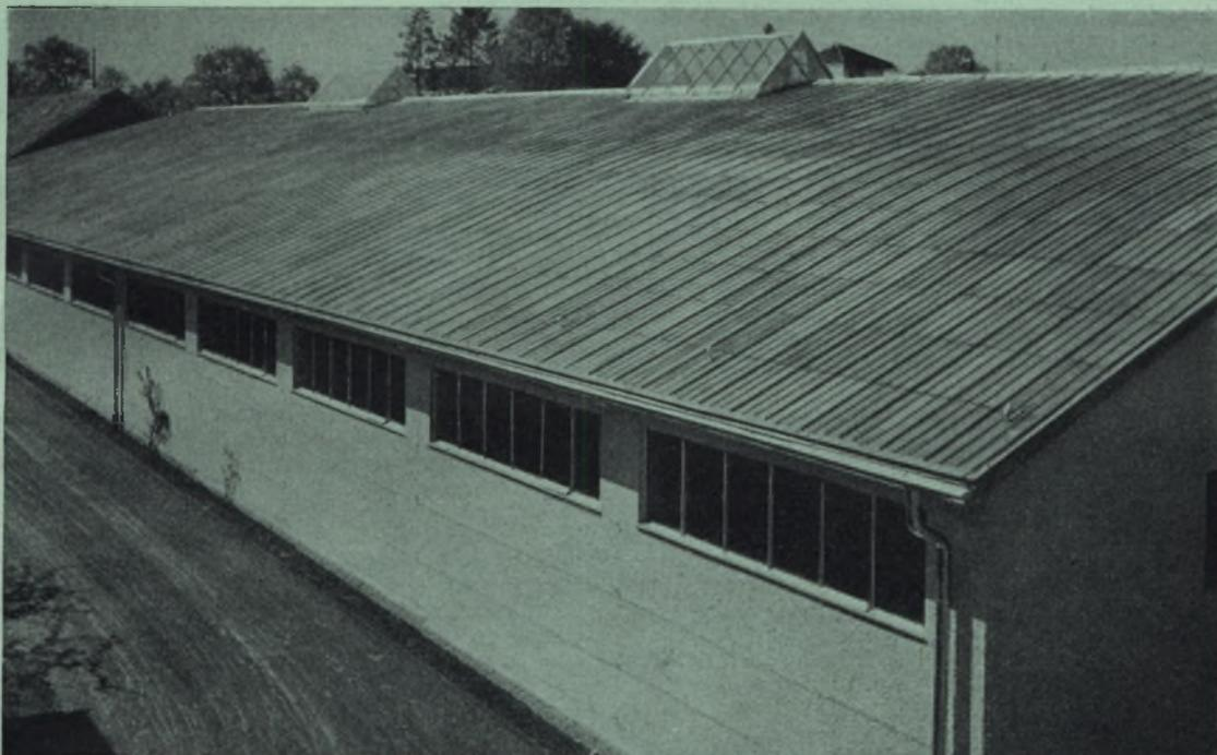
Abb. 6 zeigt das ansprechende Aeußere einer Aluminium-Tafelbedachung.
