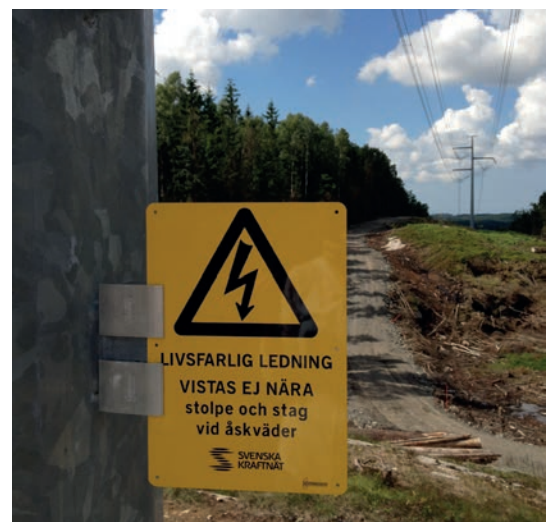
Informationsskyltar har monterats upp på kraftledningens stolpar.
