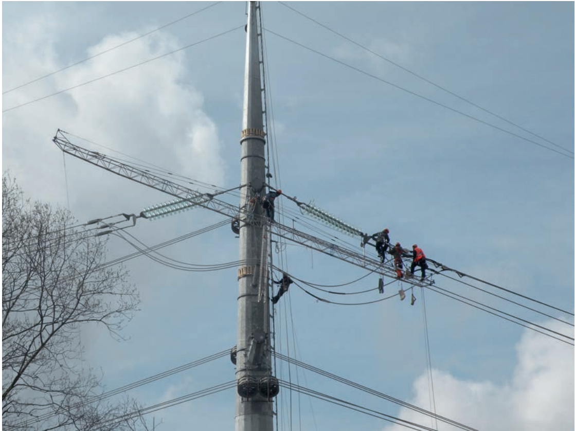
Nu har montörerna klättrat klart i ledningen. Fotot visar när de spände linor och monterade så kallade spännisolator kedjor.
